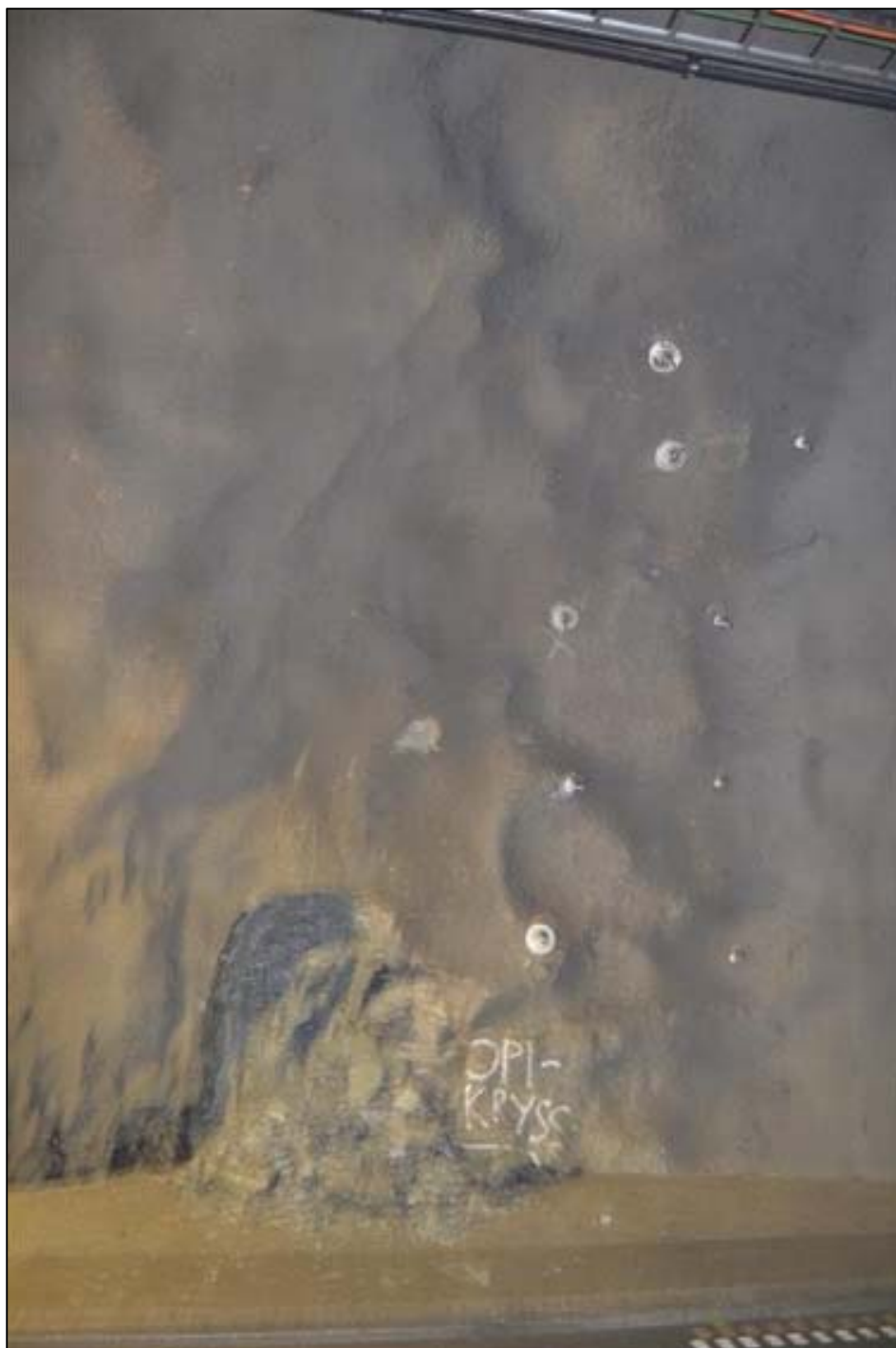
Bilde 3. Bolter som er satt i veggen over rasstedet er ikke gyste.
