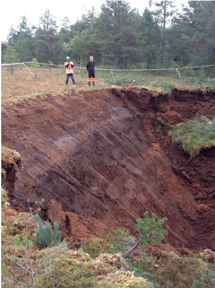
Under graving, helning 1:1,5
