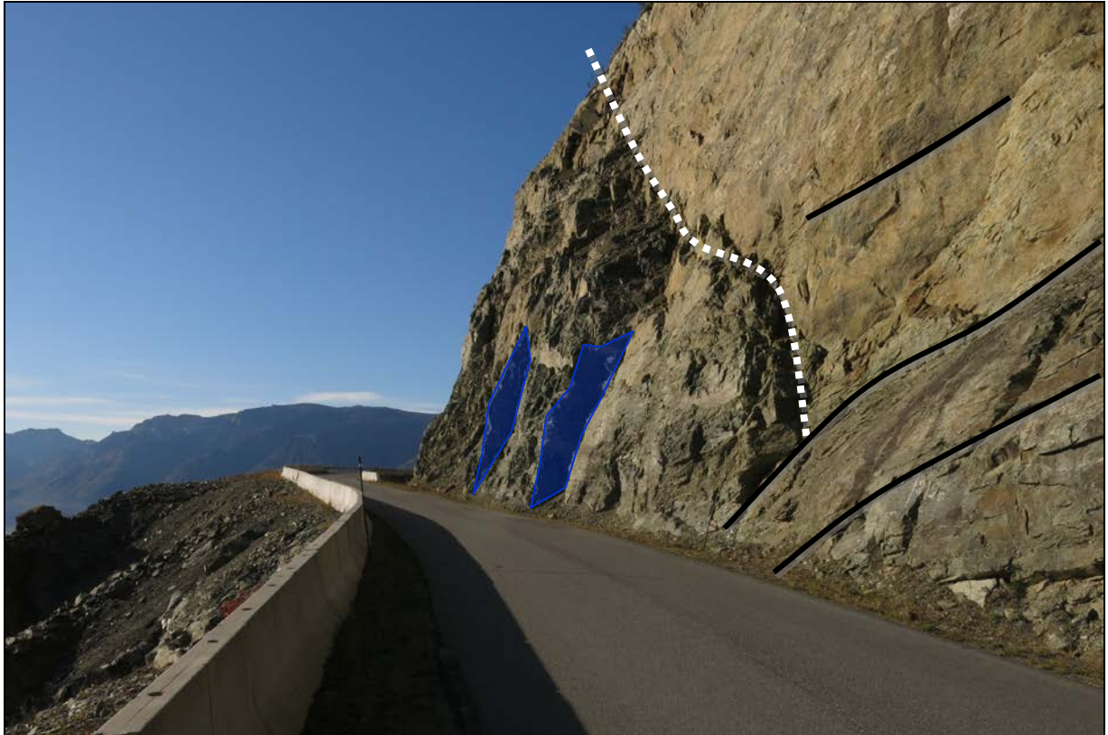
Figur 5: Nærbilde av de viktigste strukturene målt i berget ved Vannbergan, her ved profil 21 230, med sikt mot nord. F1 er foliasjon, i svart. S2 er i blått. S3 i kvitt er skjærsone.
