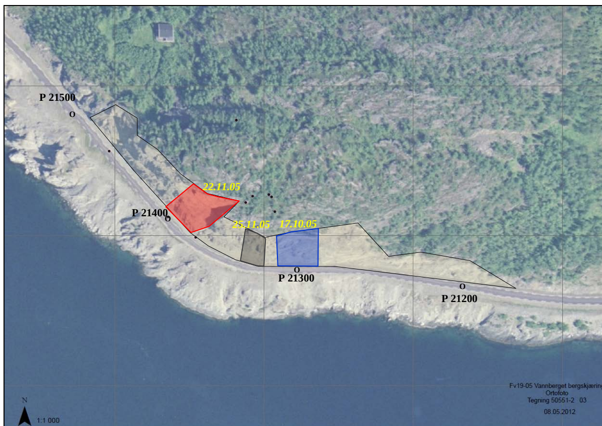
Figur 2: Foto av fv. 19 med Vannbergan og den 550 meter lange bergskjæringa (markert i lysebrunt). Blå, rød og grå oktogon angir skredområder med skreddato i kursiv over. Svarte ringe angir profilnummer på veien.
