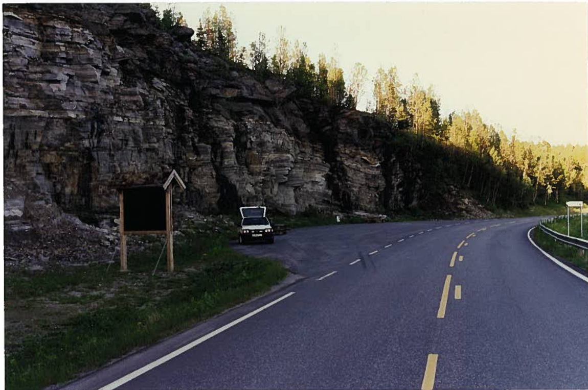
Fig. 5. Bildet er tatt mot SØ og viser en oversikt over massetak/veiskjering IV ved Andsvatnet. Merk den planskifrige metaarkosen i skjeringens nedre del, ca. 10 m mektig, over denne ligger en ca. 5 m mektig glimmergneis.
