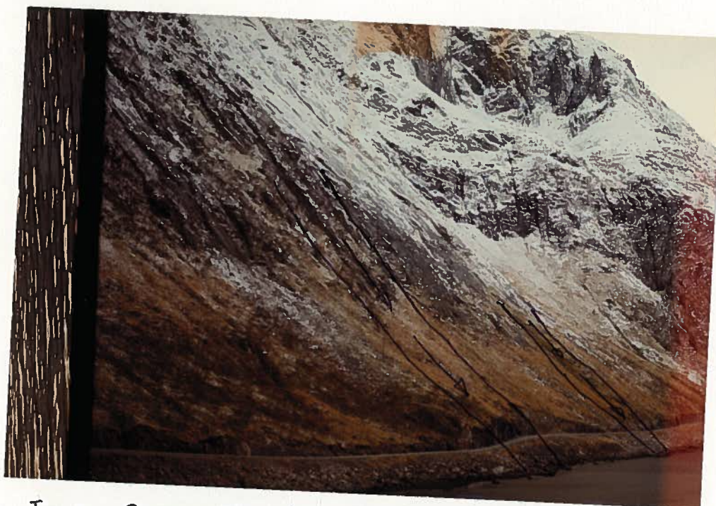
Fig 2. Rasområde km pel · 1.6 - 2,2 . Bilde tatt ved tunnelen .
