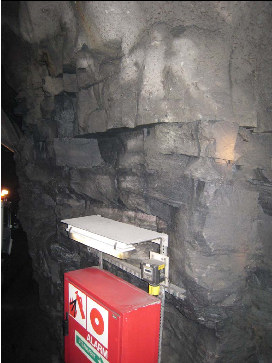
Foto 2: Ca ved km 17,210, brannskap montert i løst berg.
