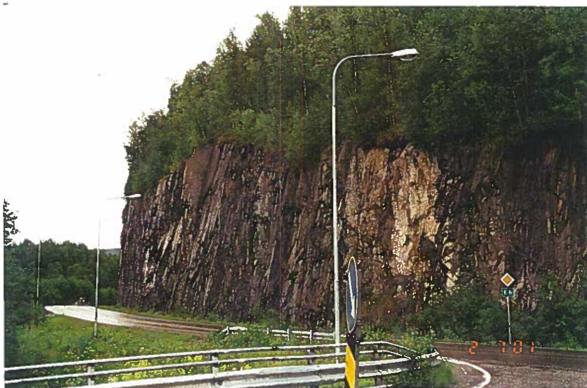
Fotobilag: To oversiktsbilder fra fjellskjæringen
