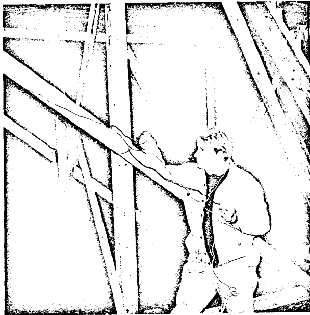
Foto 4. Kontroll-lampen kobles til ledningene ved stolpen midt i stillaset.
