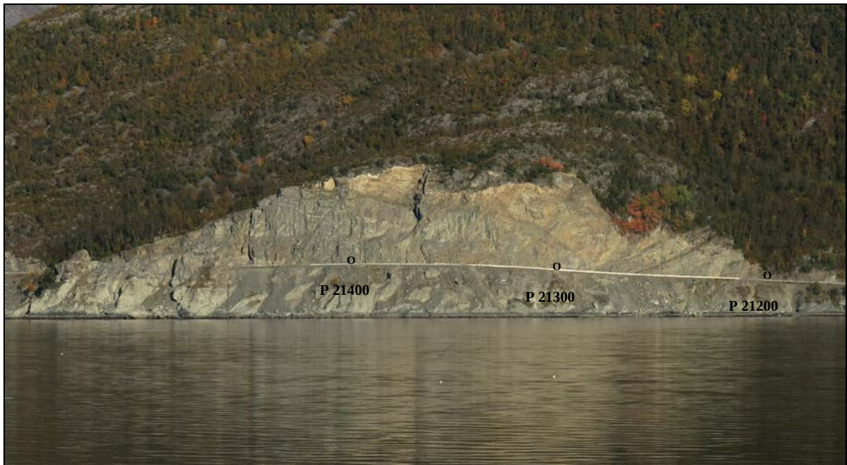
Figur 3: Foto av fv. 19 med bergskjæringen og profilnummer i Vannbergan, sett fra Sommarneset mot nordøst.
