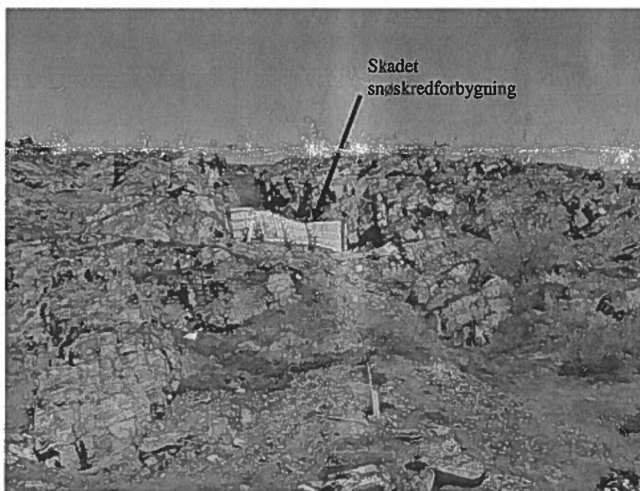
Foto 6. Skredområdet i Fuglenesvegen med den skadede snøskredforbygningen.
