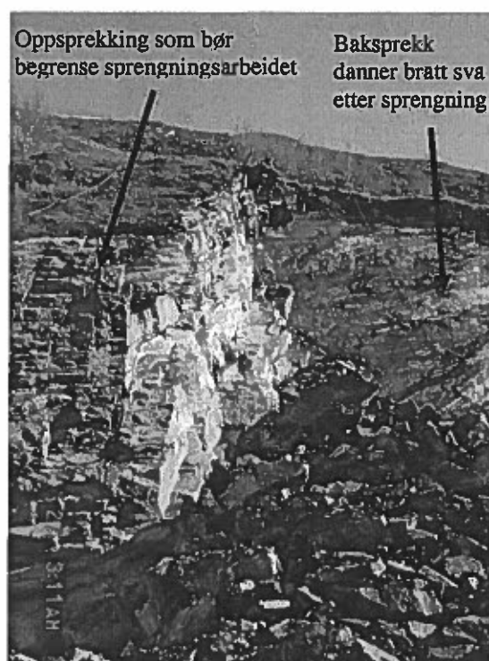
Foto 1. Klinkastupet der nedspregning foregikk i en hammer med veldefinert baksprekk
