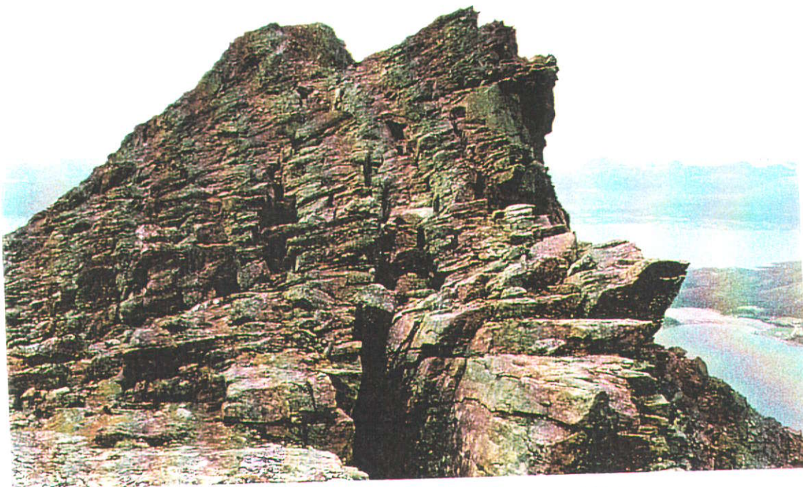
Foto 2. Tensjons-sprekker på ryggen øst for toppen på Tøtta
