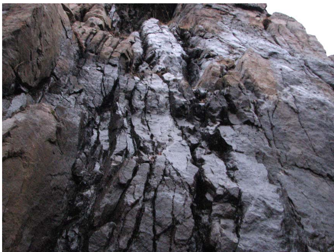
Foto 1: Søndre påhugg Rv 820 Ryggedalstunnelen. Svakhetssoner over påhugget.
