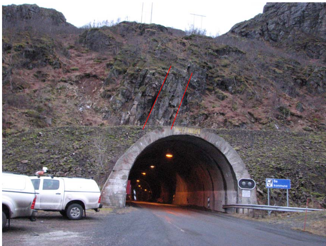
Foto 1: Søndre påhugg Rv 820 Ryggedalstunnelen. Svakhetssoner over påhugget.
