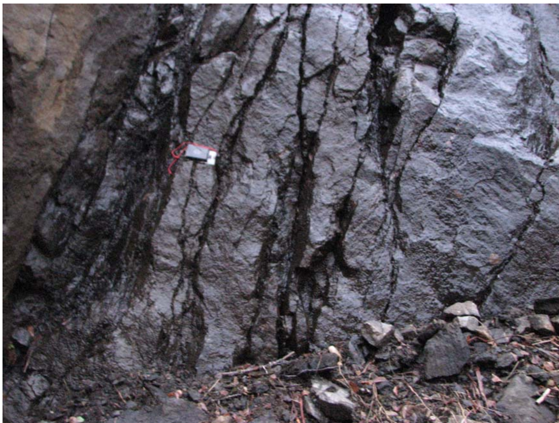
Foto 3: Skjærsone ovenfor tunnelpåhugget.
