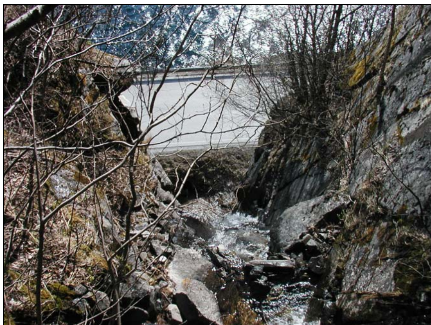
Foto 2: Utsprengt bekkenedløp ved km 19.377, sett ovenfra.
