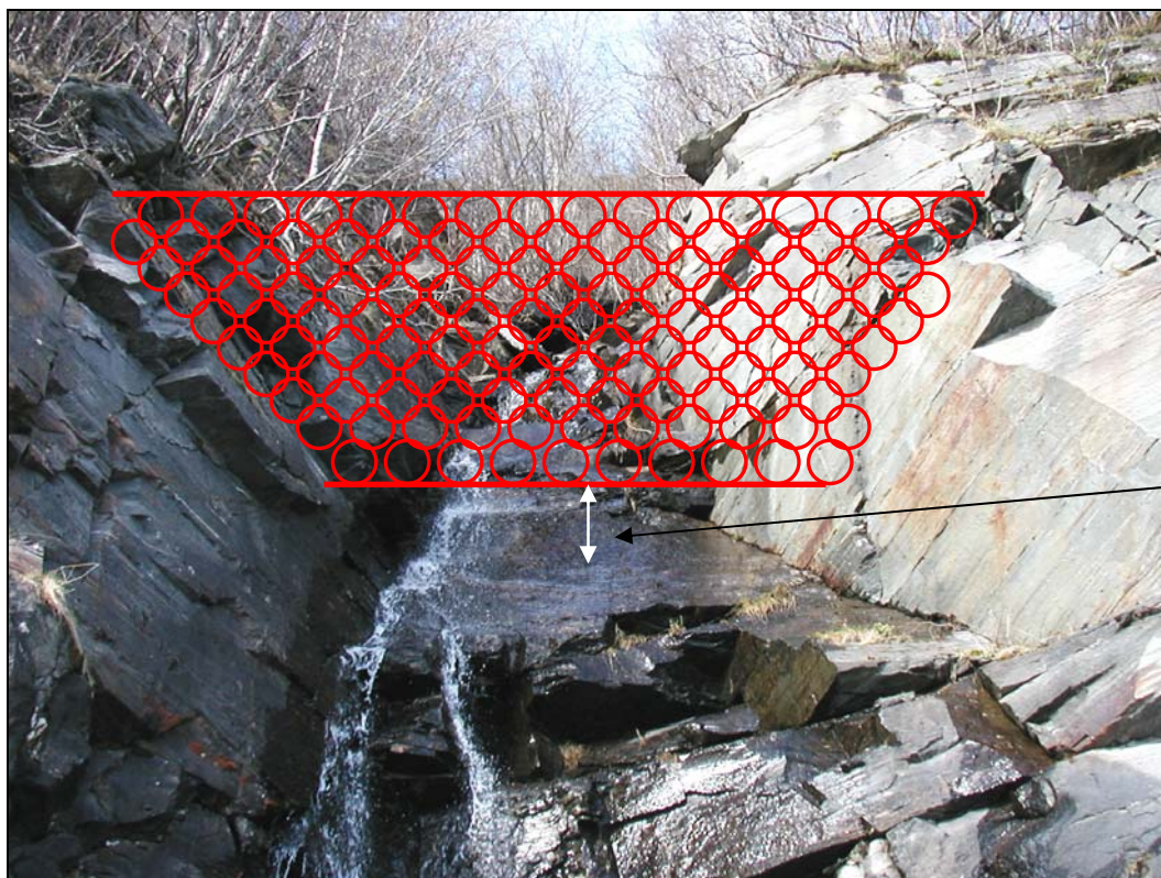
Foto 1: Utsprengt bekkenedløp ved km 19.377.
