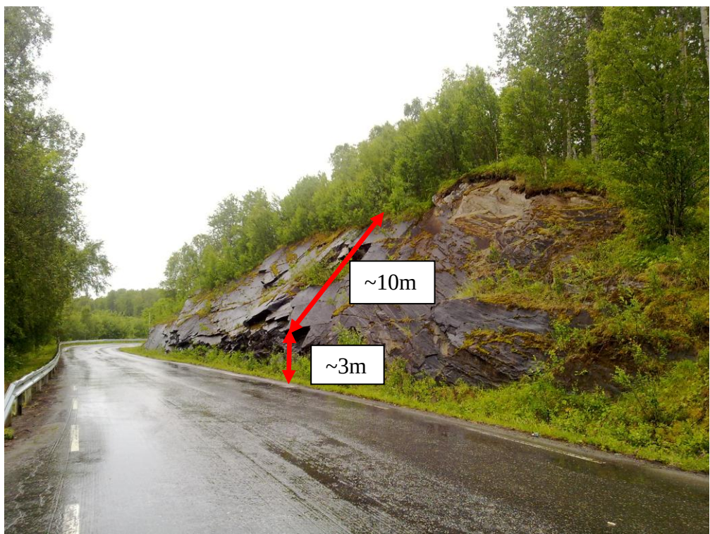
Foto 1: Fv819-01 ~km 7.950. Oversiktsbilde bergskjæring og naturlig skråning. Bilde tatt mot NØ
