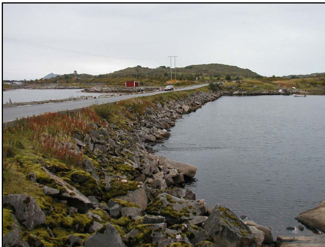
Bilde 1: Oversiktsbilde av vegfylling over Husvågen sett fra nord.
