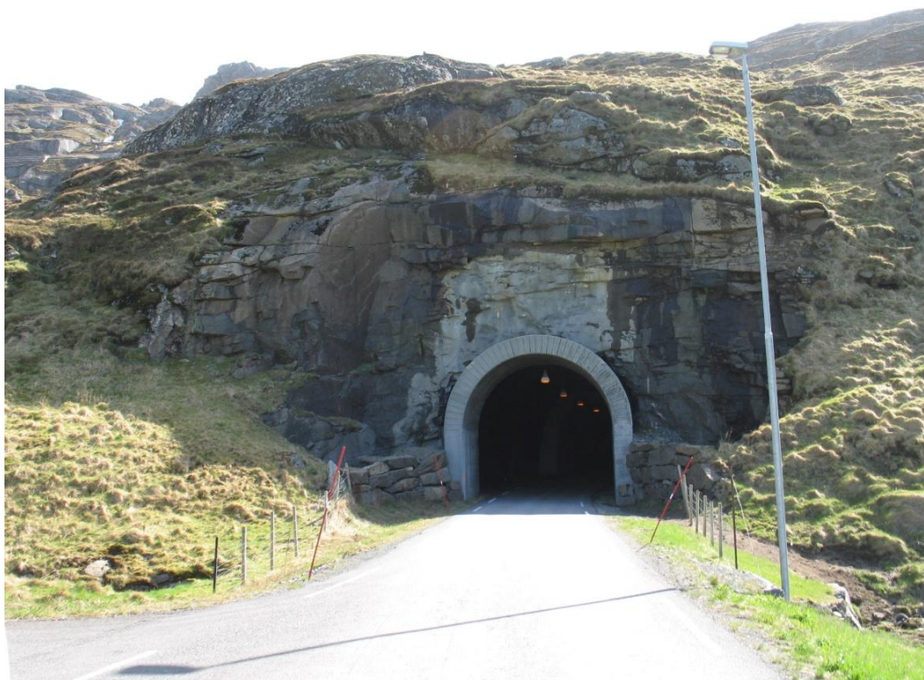
Foto 6: Tunnelåpning mot nord (Utaaleiv)
