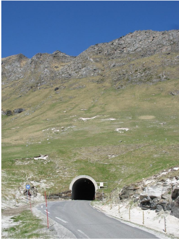
Foto 1: Tunnelåpning i sør
