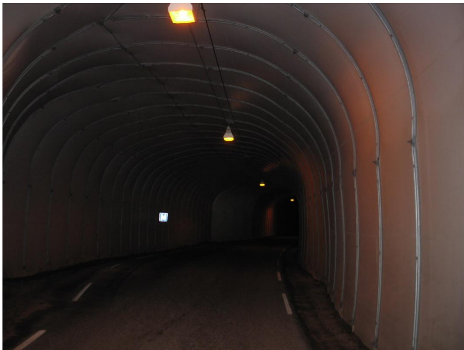
Foto 2: Fra pel 35 og innover tunnelen mot nord
