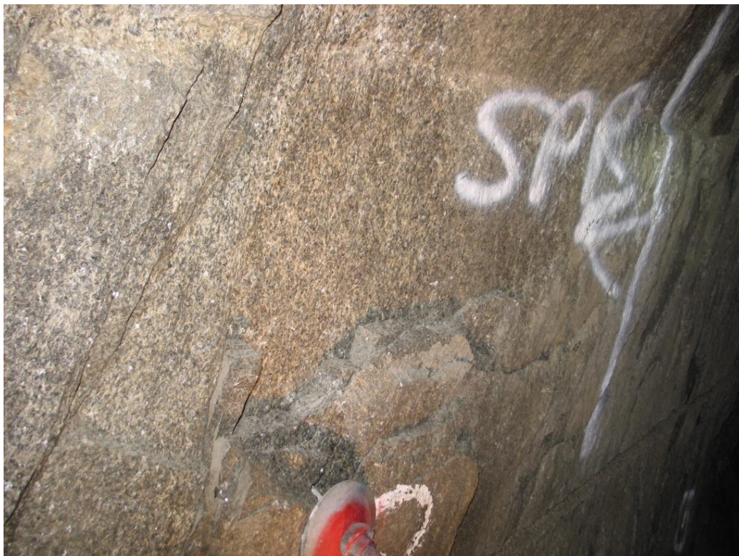
Foto 5: Område med sprakefjell påmerket for sprøyting ved pel 535
