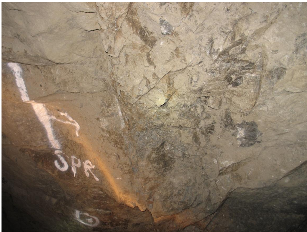
Foto 4: Område med sprakefjell påmerket for sprøyting ved pel 535
