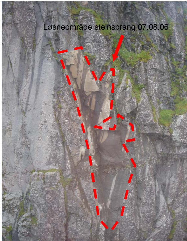
Fig. 3 Løsneområdet inntegnet. Fra veien kunne bruddflaten tyde på at det var gjennomgående åpne sprekker i bruddflaten, men fra helikopteret viste det seg at det ikke var tilfelle.
