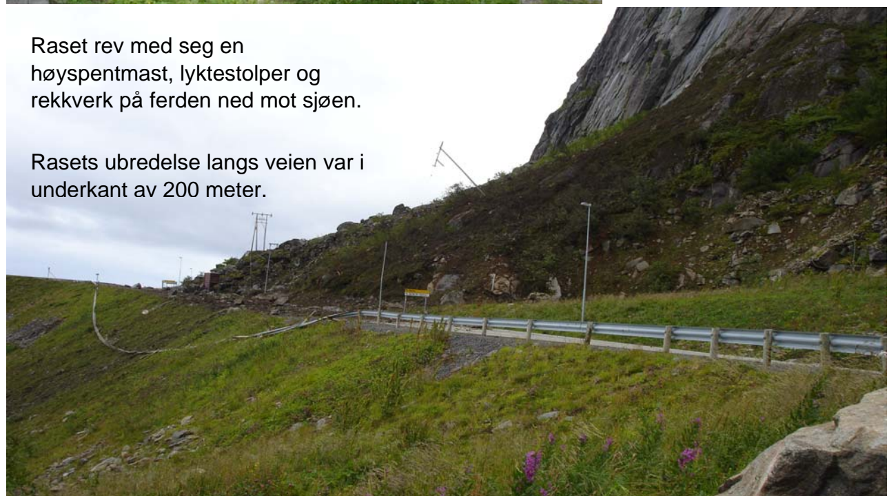
Fig. 2 Nedrevet rekkverk, høyspentledning og lyktestokker. Blokker på og nedenfor veien.
