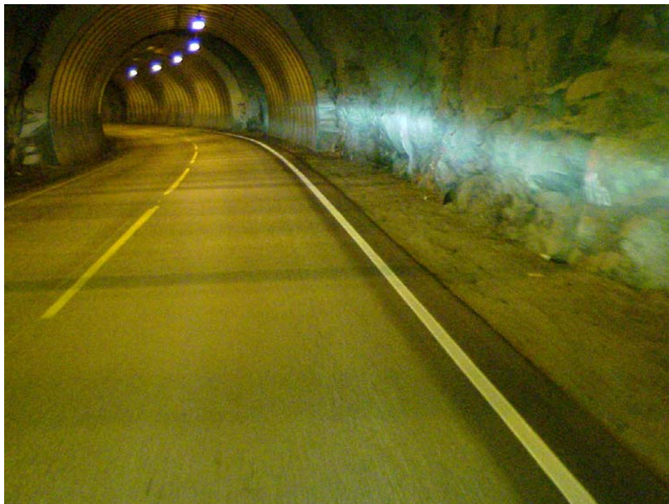
Foto: Eksempel på giertsenduk og veggkontur i tunnelen.
