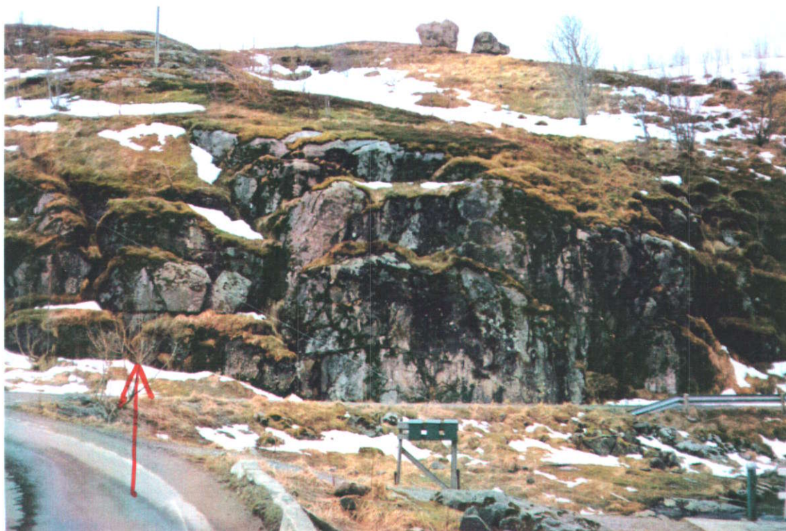
Foto 1. Påhugg A med endel blokker i påhuggsområdet . Bak blokkene godt tunnelfjell.
