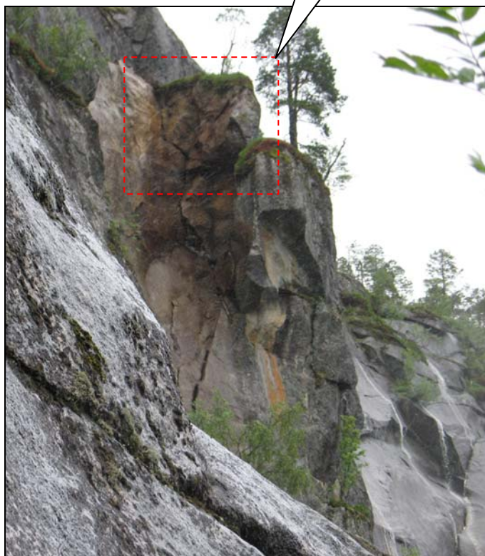
Foto 6: Vestre sidekant av løsenområdet. Bildet tatt fra fjellhulle øst for løseområdet.
