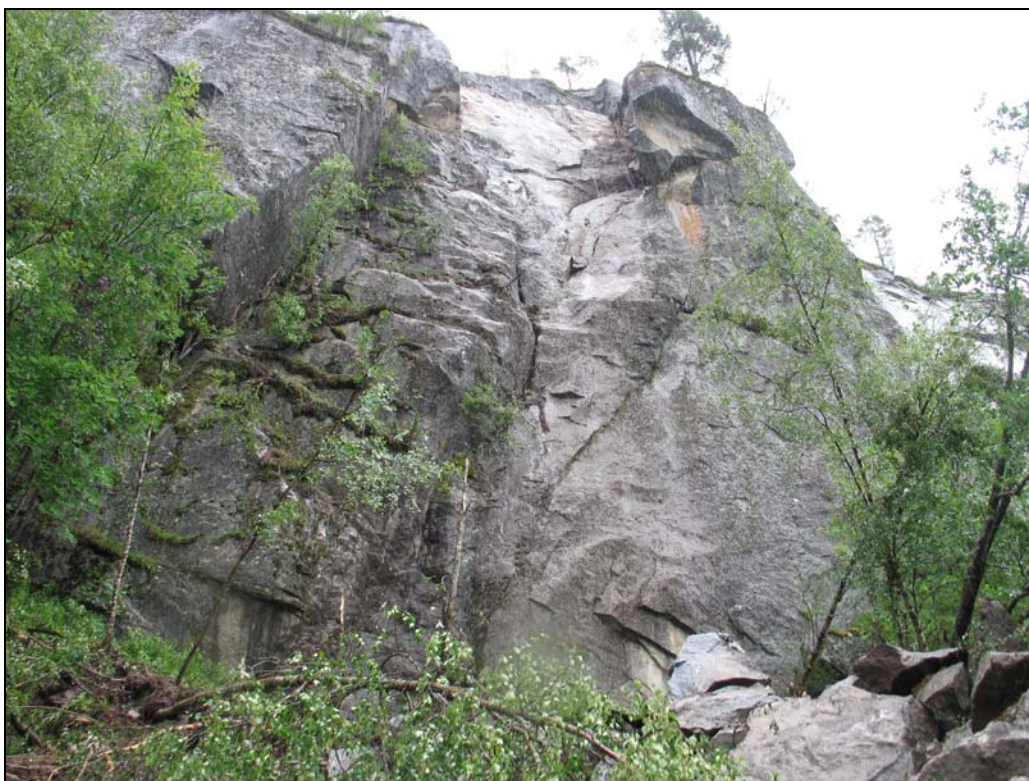
Foto 4: 30 m høyt fjellflåg med løsneområdet i øvre halvdel.
