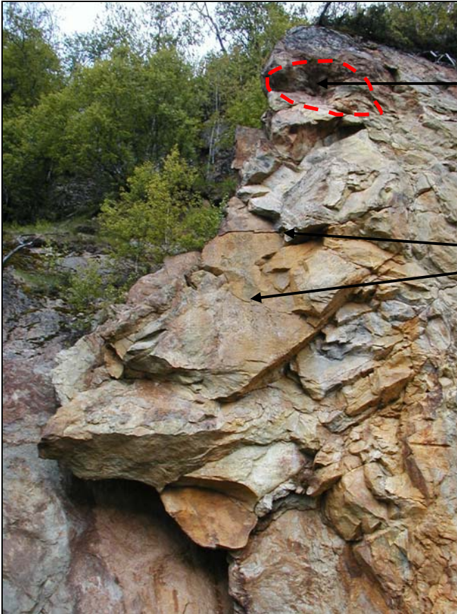
Foto 3: Ca. 18 m høy skjæring med ustabile blokker ved km 2.040.
