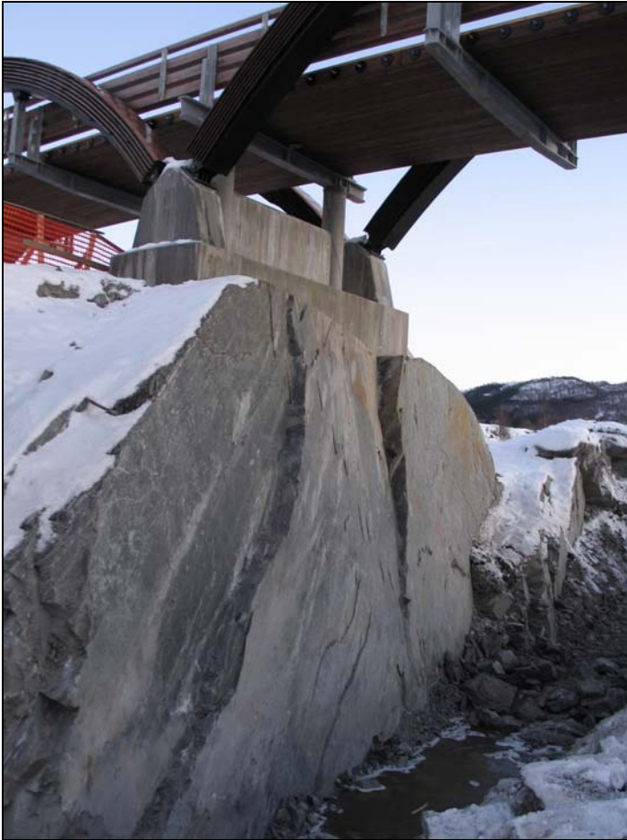
Foto 7: Fjellskjæring ved fundament for Løkåsheia bru.
