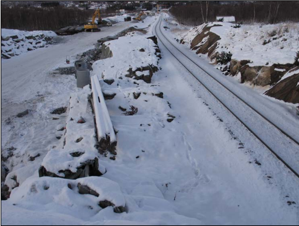
Foto 1: Fjellparti mellom veg og jernbane nord for Løkåsheia bru.
