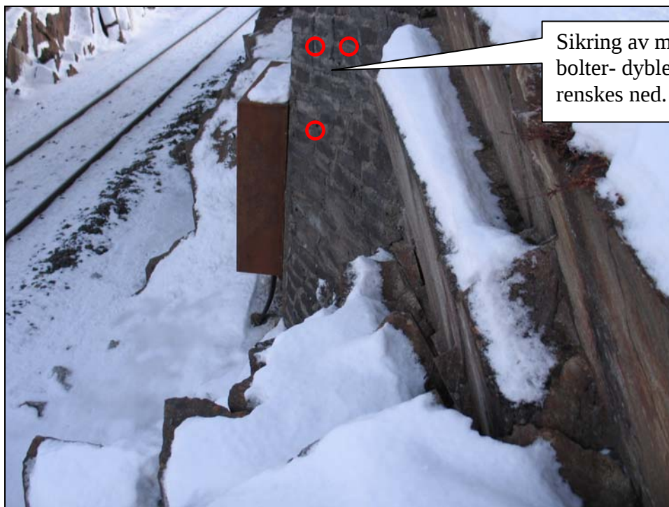
Foto 4: Forblendet mur med stein ved fundament for Løkåsheia bru.
