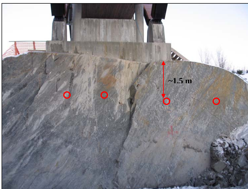
Foto 6: Fjellskjæring ved fundament for Løkåsheia bru.
