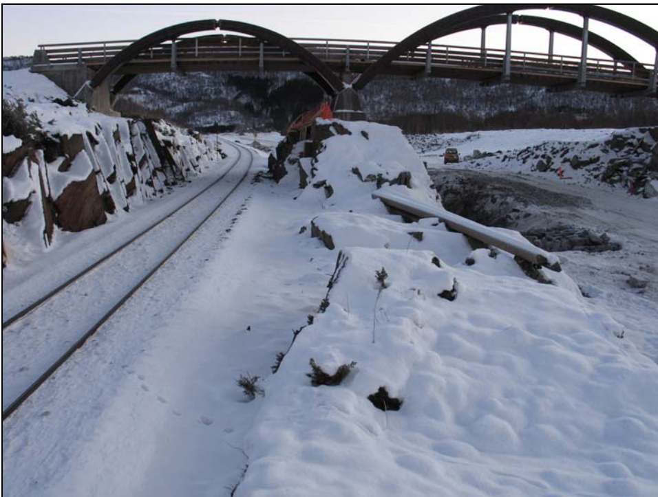
Foto 2: Fjellparti mellom veg og jernbane nord for Løkåsheia bru.
