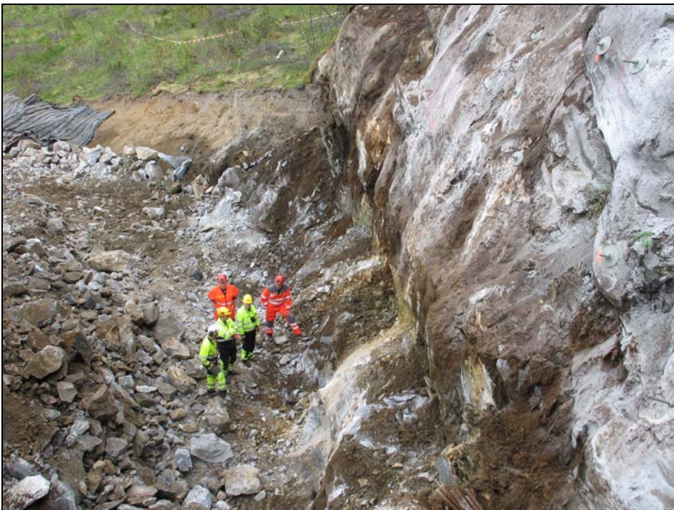
Foto 8: Østre del (venstre) av tilpasset påhuggsflate
