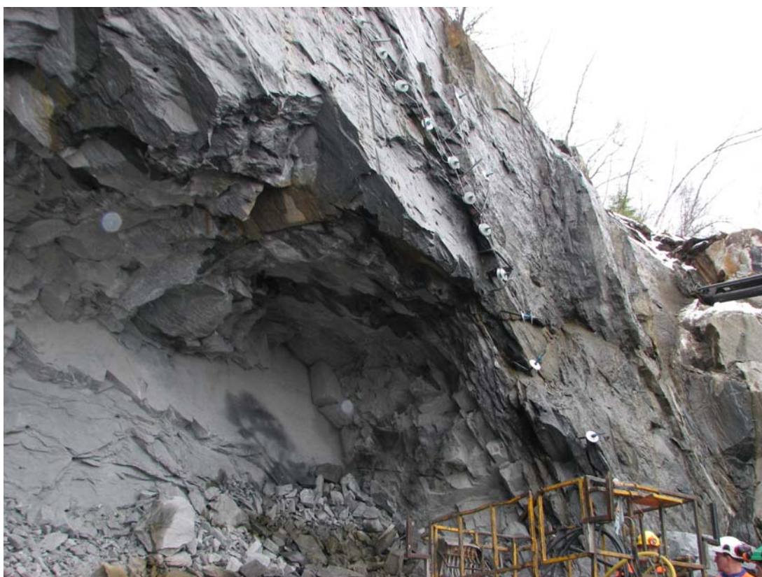
Foto 4: Høyre side påhugg.
