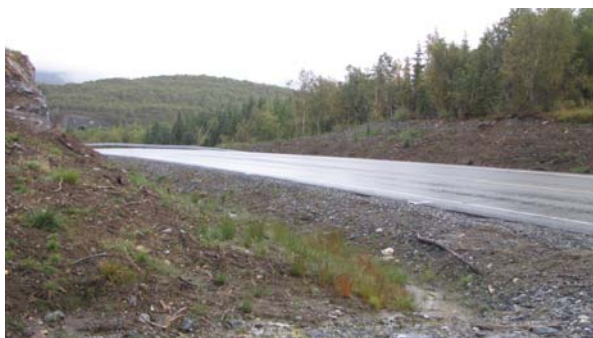
Oversiktsbilde over telehivområdet med grøfter
