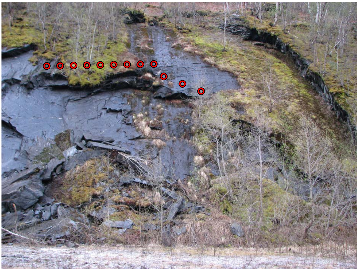
Foto 7: Forslag til sikring av øvre bruddkant.
