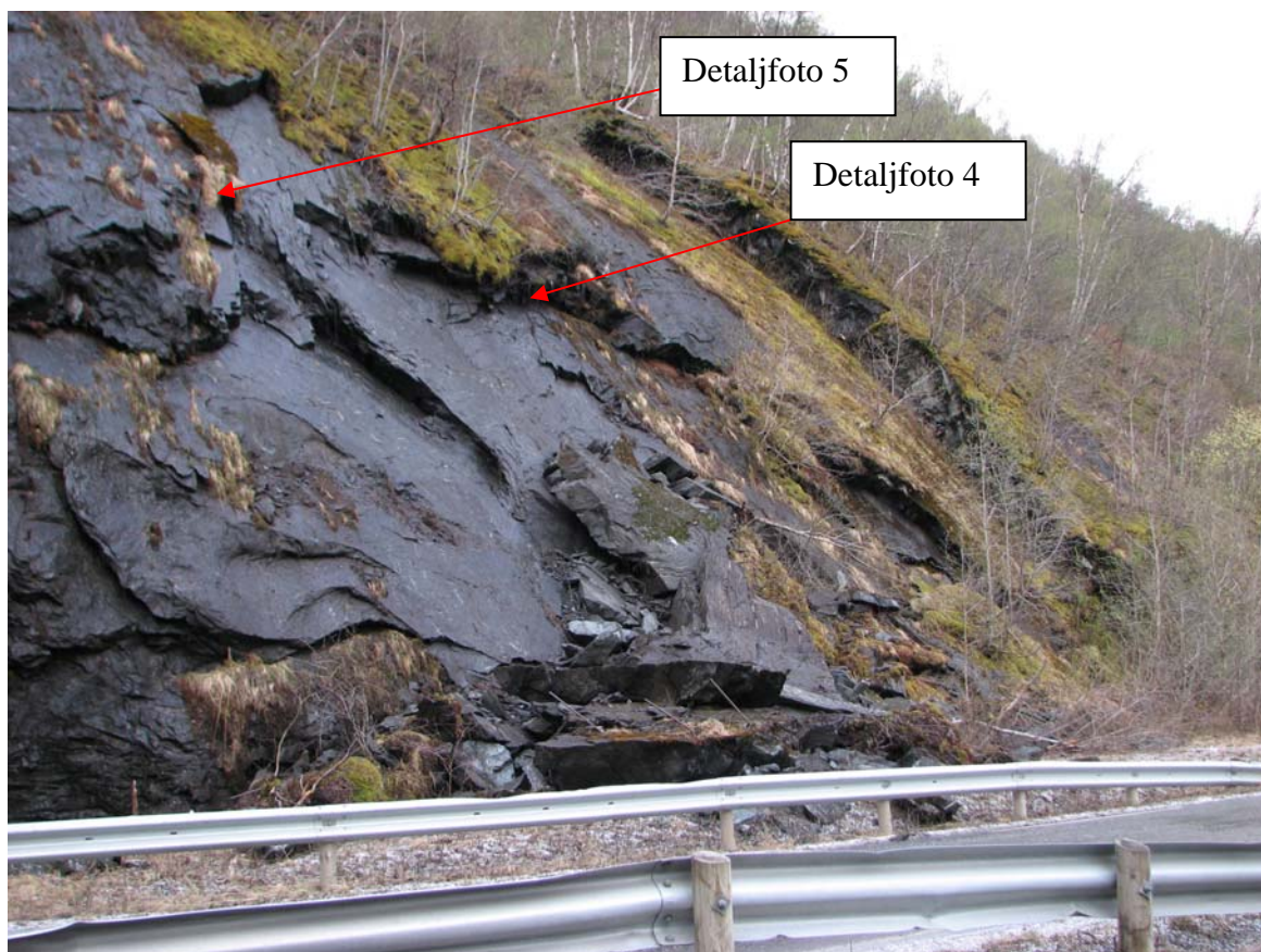
Foto 3: Oversiktsfoto bruddkant over detaljer vist i foto 4 og 5.
