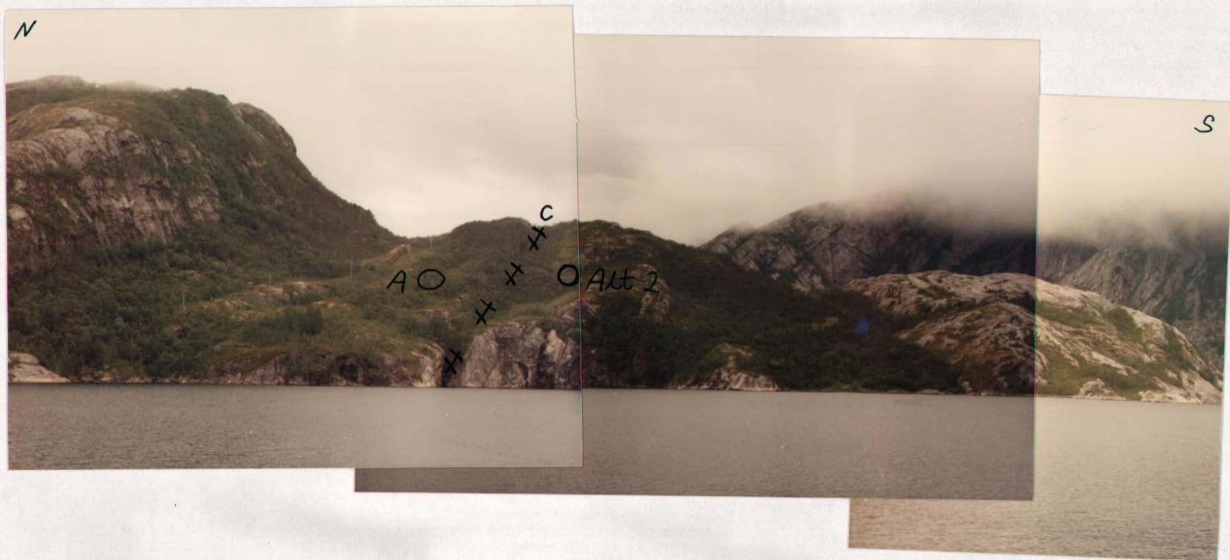
Foto 3. Bildet viser topografien i området og lokaliseringen av påhugg A og påhugg for alternativ 2. Svakhetszone c er markert. Fotografert mot Ø.
