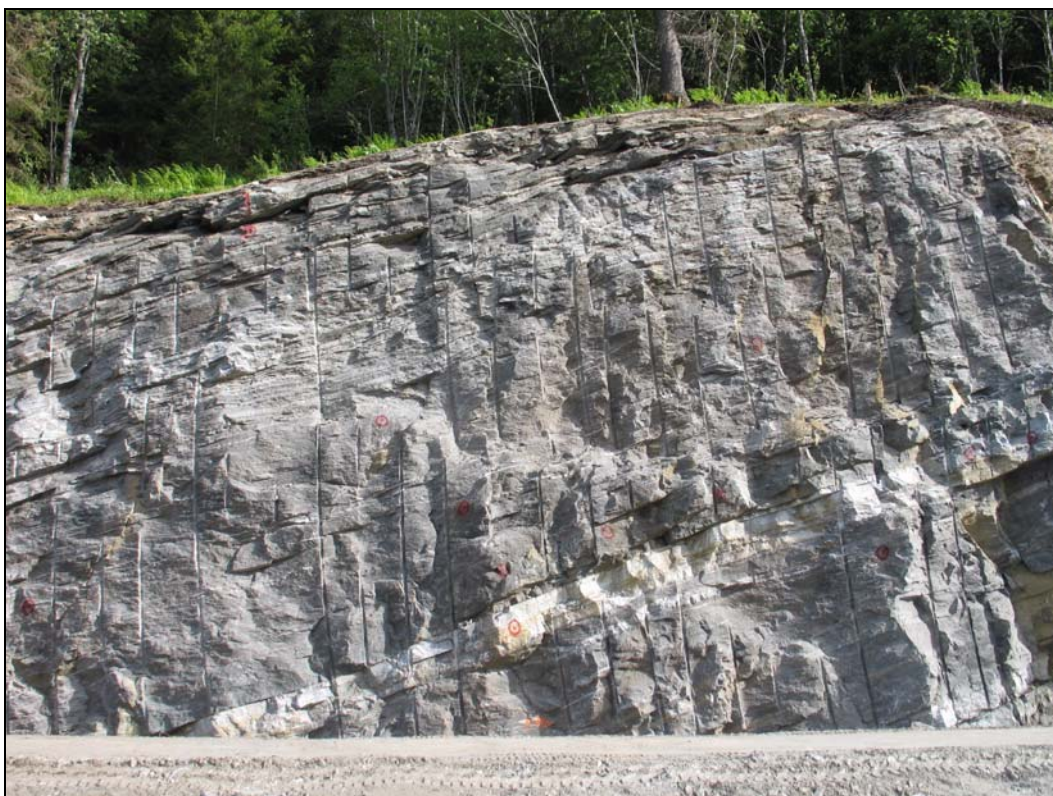
Foto 1: Deler av søndre bergskjæring. Eksempel på merking av bolt. Rød strek mellom boltesymbol indikerer fjellbånd.
