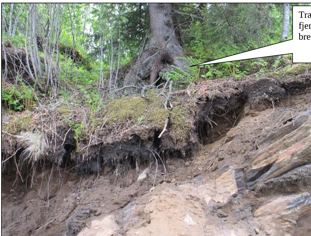
Foto 12: E6-08 Nordre bergskjæring. Ved stor grantre. I 10-12 m bredde anbefales det at isnett føres over og forbi skjæringskanten og innpå torvkanten.
