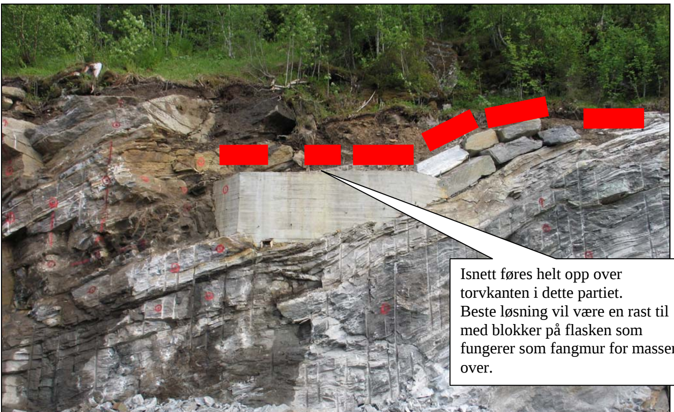
Foto 8: Betongmur ved nordre bergskjæring
