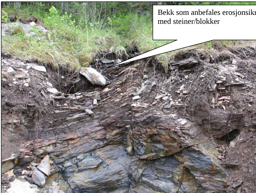
Foto 2: Søndre bergskjæring. Bekk ved pel 370, ca midt i skjæringa.
