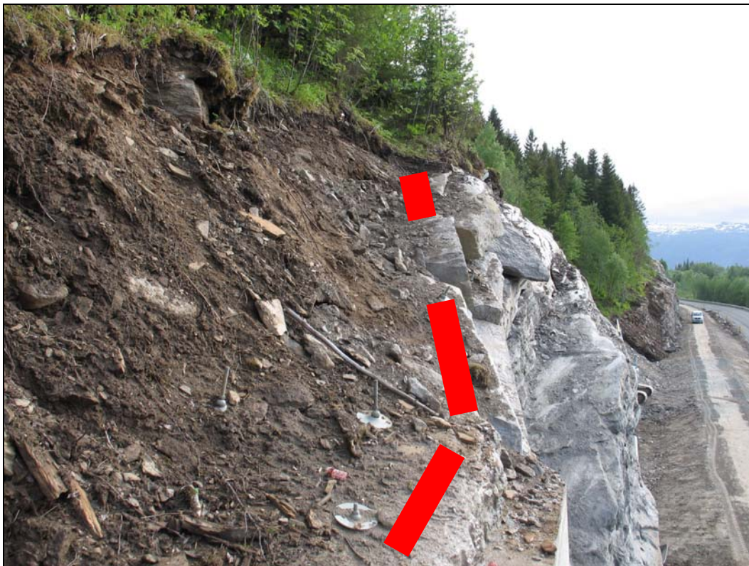
Foto 9: Betongmur ved nordre bergskjæring
