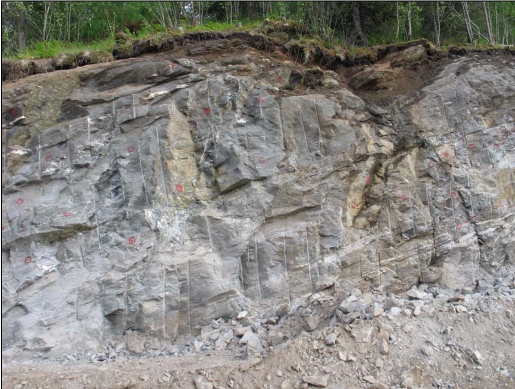
Foto 7: Deler av nordre bergskjæring, ca midt i. Eksempel på merking av bolt
