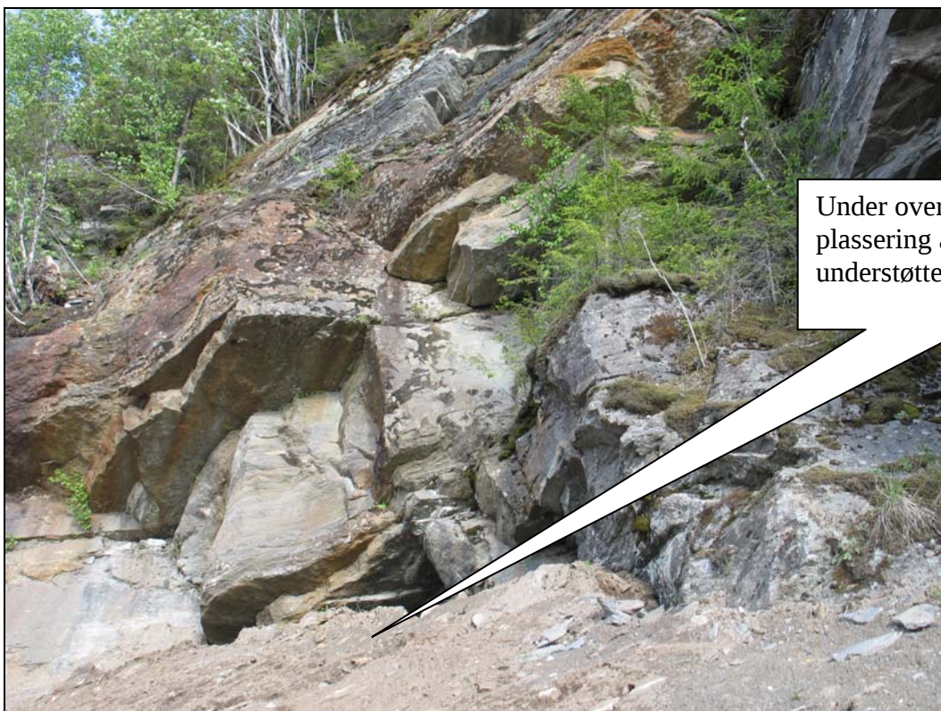
Foto 6: Overheng i søndre del av nordre bergskjæring
