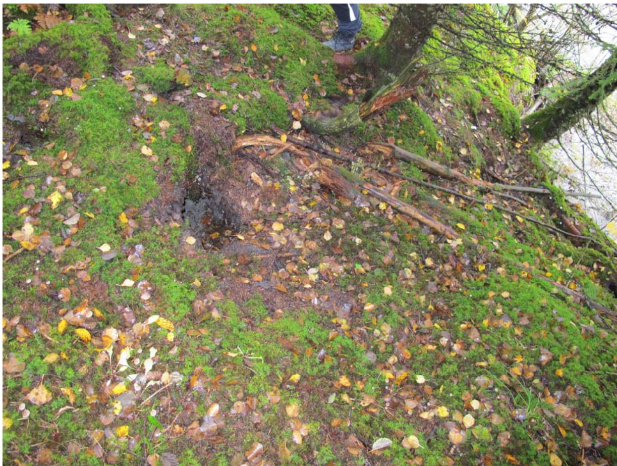
Bilde 2: Oppsprekking i terrenget mellom fylkesveg og Røssåga
