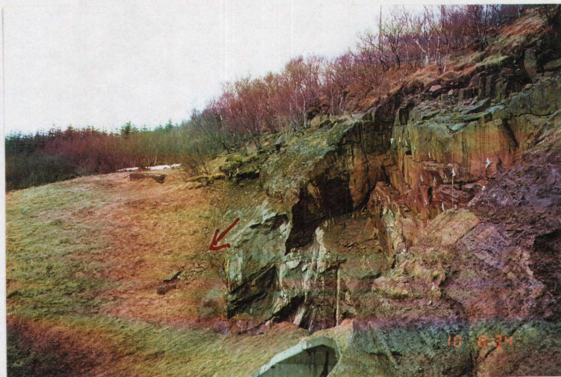
Fig 2. Boltet overheng sett fra siden. Pilen viser utrast parti.
