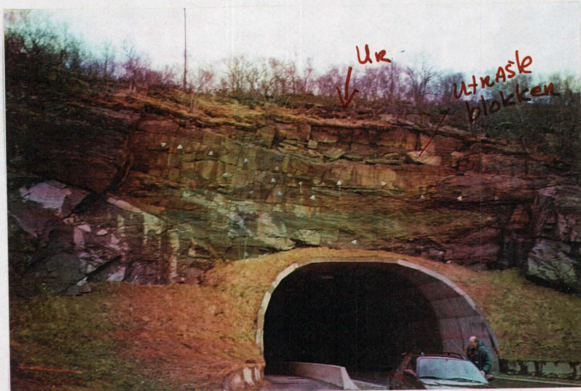
Fig. 1. Viser bolting av det steile til noe overhengende fjellpartiet over påhugget. Utraste blokker fra kanten og ura.
