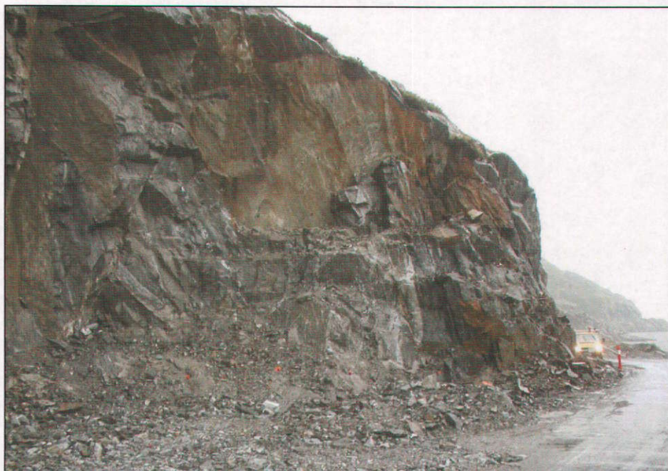
Foto 1: Gjenstående skjæring ved pel 5800 mellom Enge og Steinvikbekken. Bilde tatt på vestsiden.
