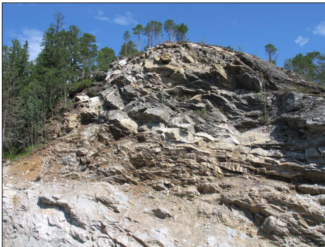
Foto 3: Oversikt over høyeste del av fjellskjæringen.
