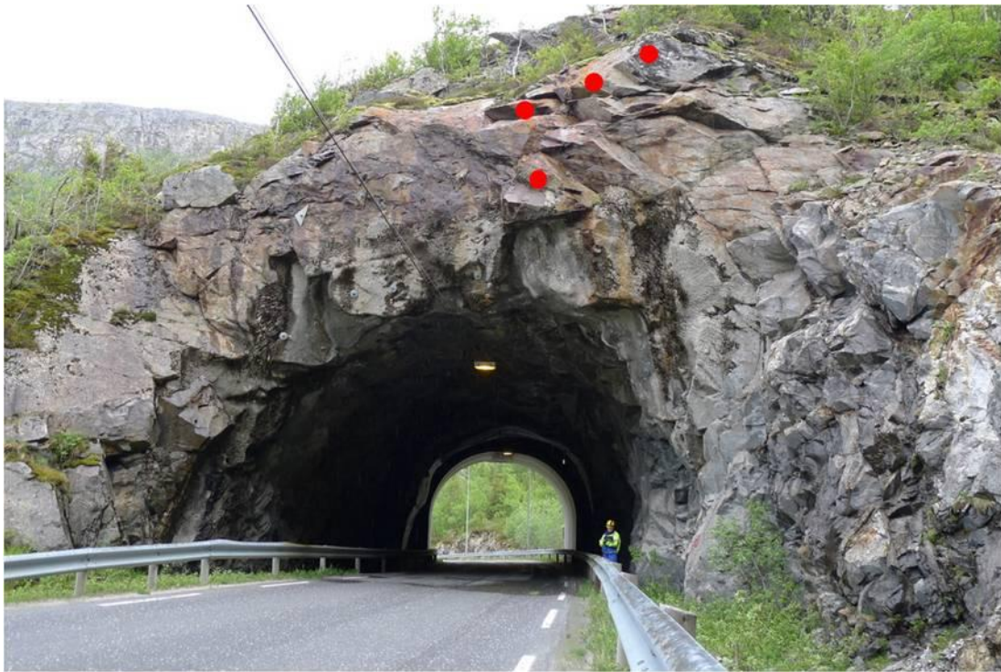
Bilde 3: Påhugg i sør med 4 innregnede bolter
