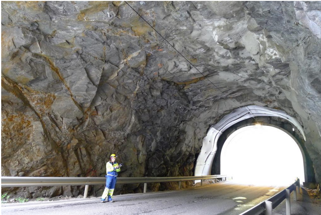
Bilde 1: Vegg og heng, tatt mot nordvest
