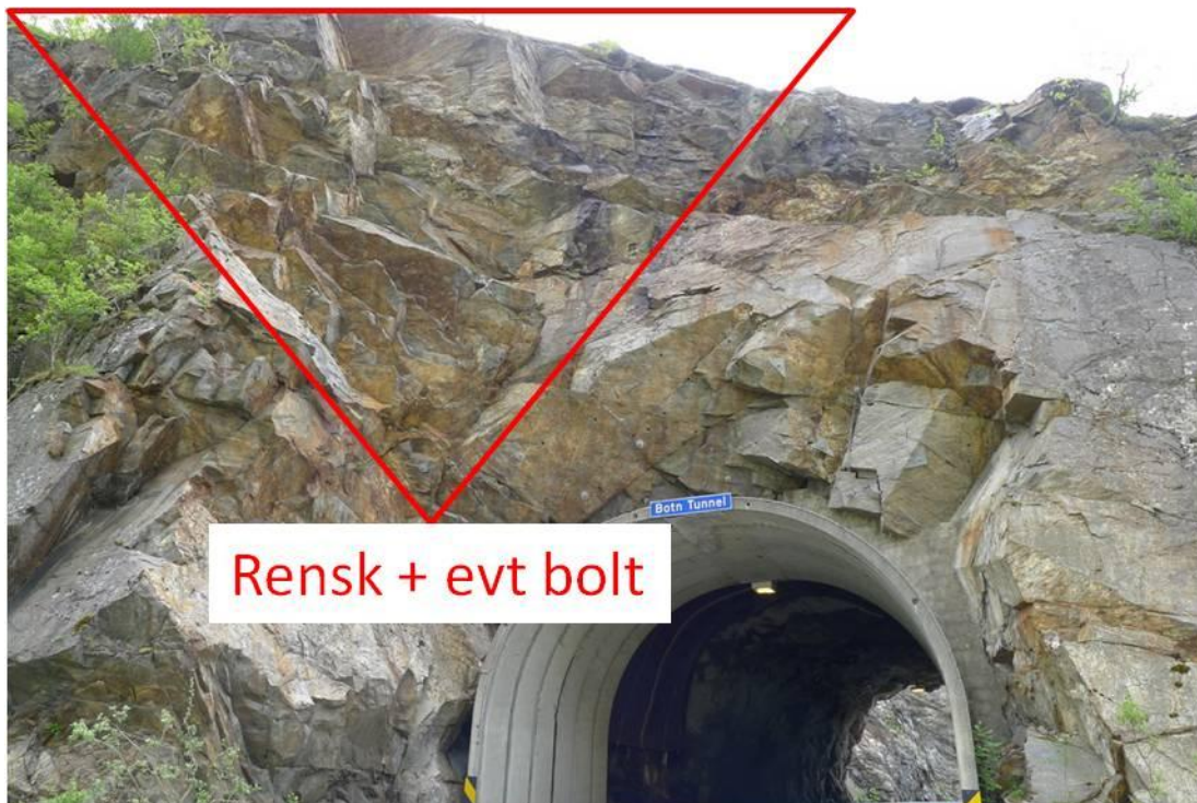
Bilde 4: Påhugg i nord. I overheng markert med trekant anbefales rensk og i tillegg bolter der det ansees som nødvendig.
