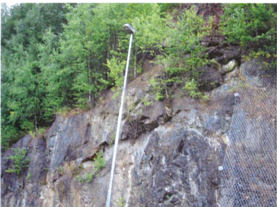
Boltebehov sentralt på bildet
