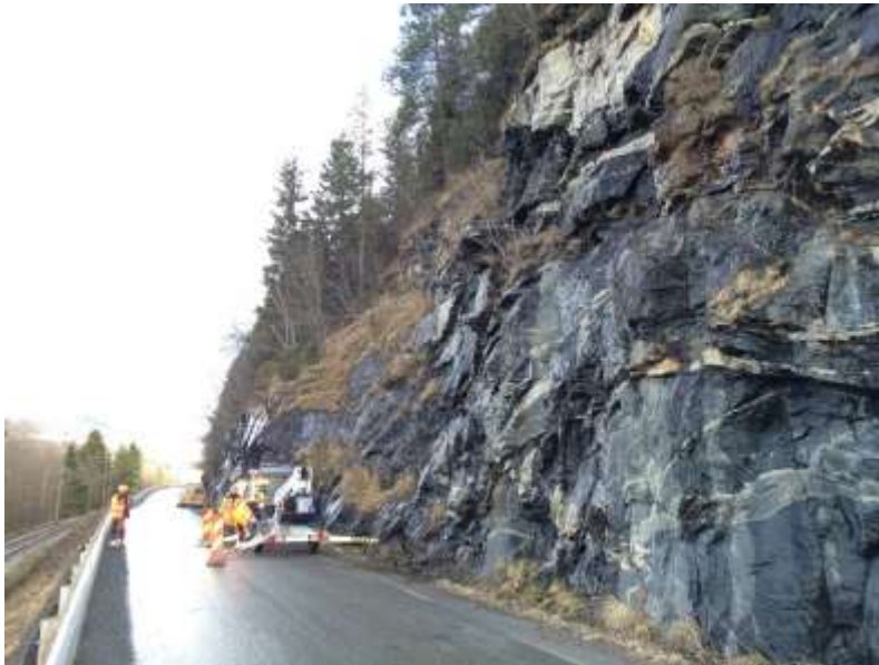
Figur 3: Oversiktsbilde som viser terrenget og aktuell del av skjæringa. Bildet er tatt mot nord.
