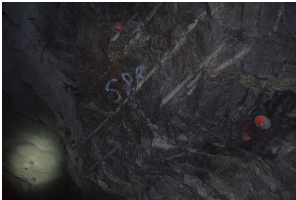
Figur 5 Område med småfallent berg, bør sikres med sprøytebetong. Pel nr. 233-237.
