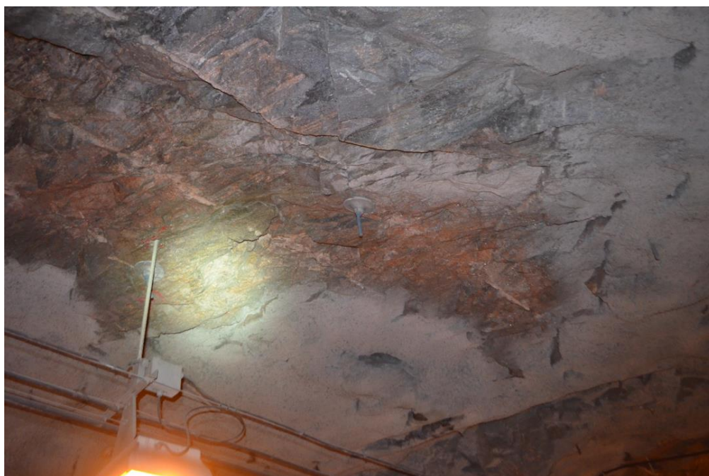
Figur 4 Område med småfallent berg, som bør sikres med sprøytebetong. Pel nr. 147-152.
