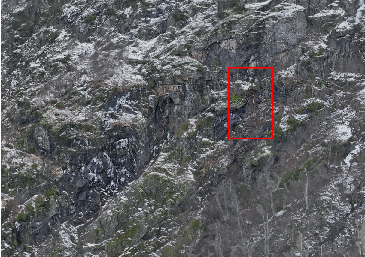
Figur 4: Løsneområde for blokk som traff vegen lørdag morgen.
