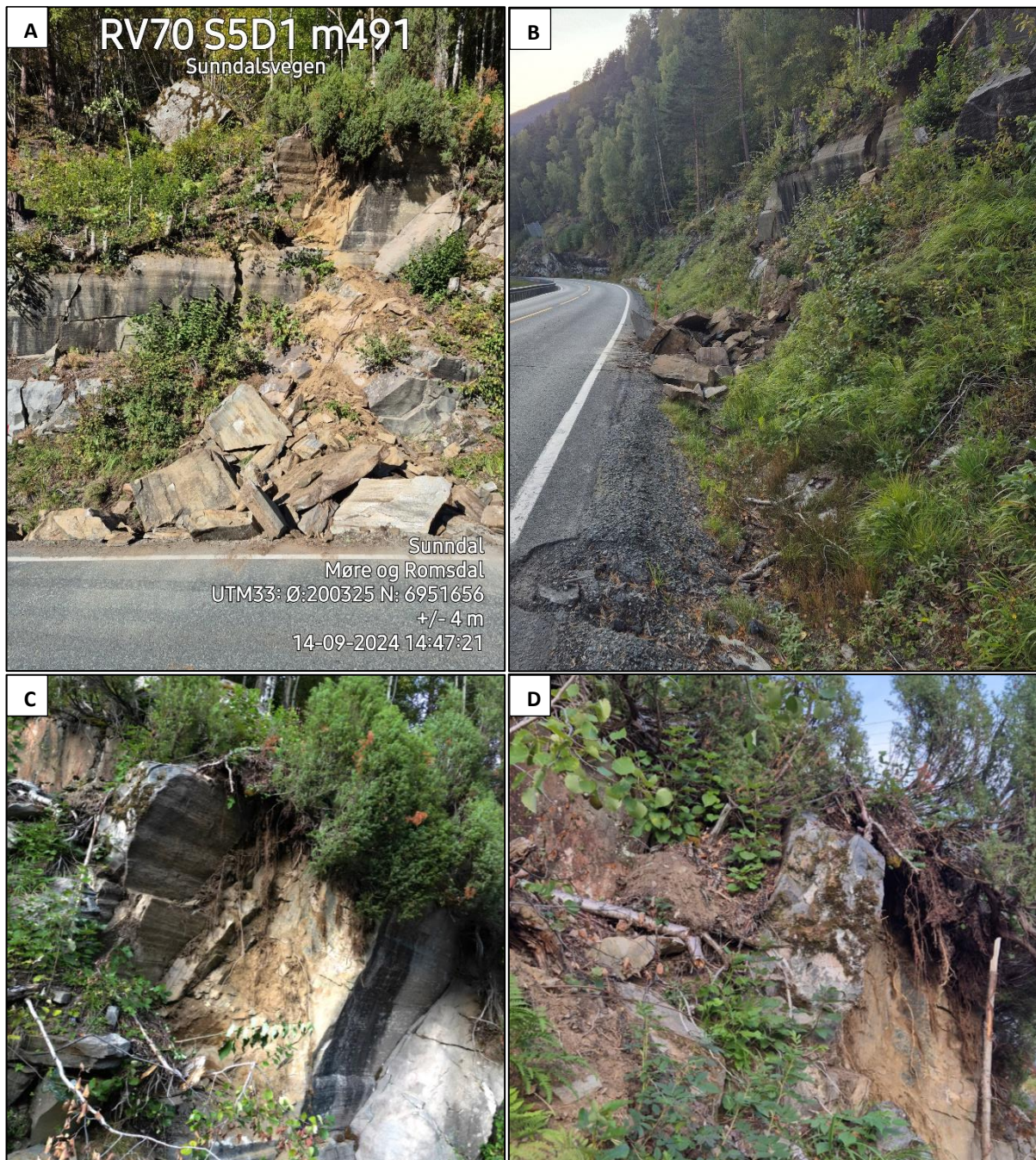
Figur 3: A: løснеområdet til steinspranget er omtrent 6 meter over veien, volumet er ca. 4 m 3 . B: Mesteparten av steinspranget landet i grøften, grøften er 2,5 meter bred og 0,5 meter dyp. C: Gjenværende blokk i løснеområdet, størrelsen er anslått til ca. 1-1,5 m 3 . D: Gjenværende blokk har «sluppet» fra torvdekke på baksiden.
