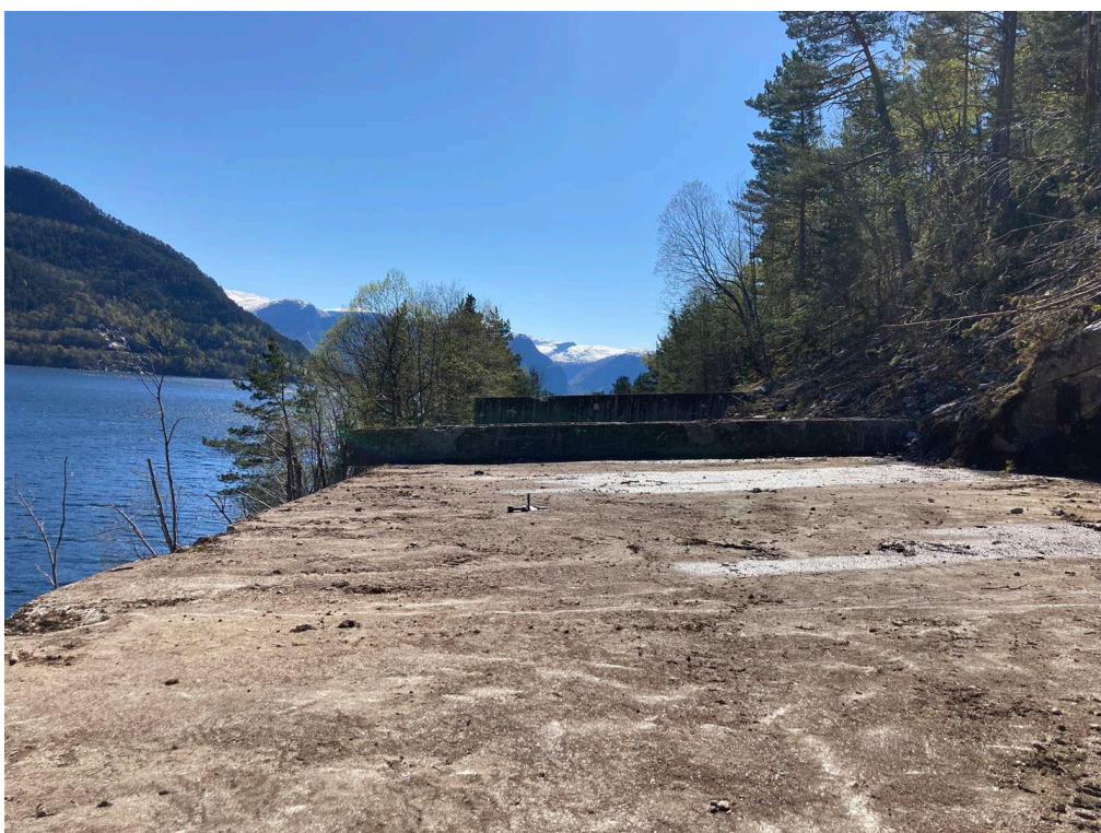
Figur 2 – Taket på skredoverbygget ble ryddet etter steinskredet februar 2023. Blide er tatt etter rydding var utført.
