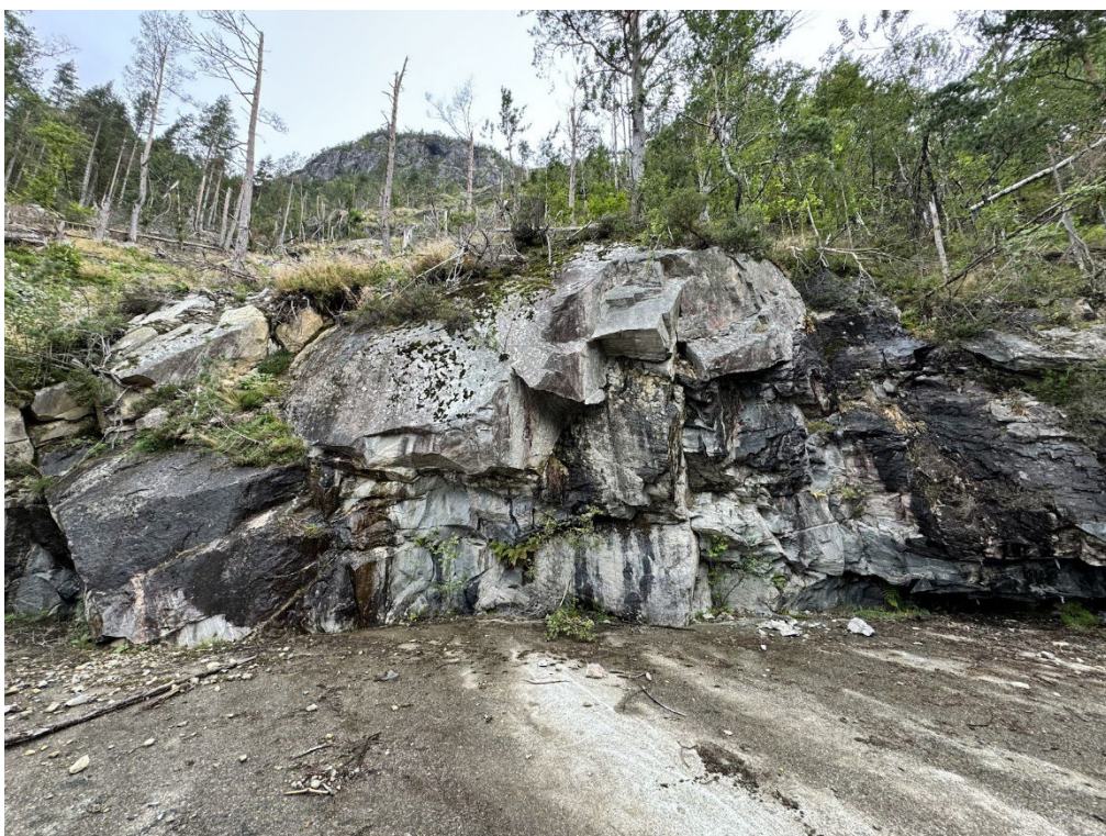
Figur 4 – Bergparti over skredoverbygget er rufsete og har en del løse steiner. Det anbefales at det ikke oppholder seg personer under her. Oppmerking ca 2 m fra bergparti anbefales. MERK: Bergpartiet kan fungere som egnet plass å søke ly ved en eventuell skredhendelse.
