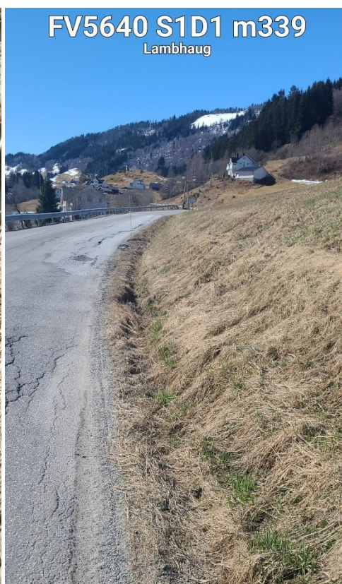
Bilde 4: Bildet viser grøft i løsmasser.
