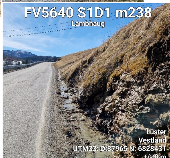
Bilde 5: Bildet viser grøft langs bergskjæring.
