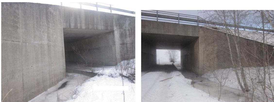
Figur 3.2 Bildet viser Hibernsbekken kulvert. Innløpet på venstre og utløpet på høyre side.
