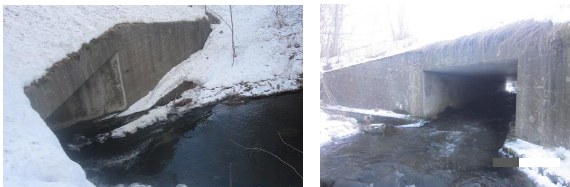
Figur 3.1 Bildet viser Melhus kulvert. Innløpet på venstre og utløpet på høyre side.
