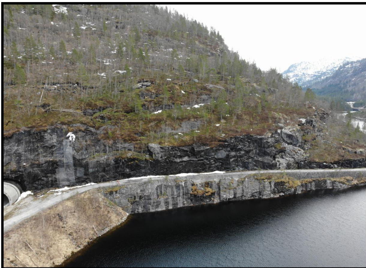
Figur 5 – Oversikt over nordleg del av området. Oppsprukke blokkparti til høyre i bildet. Foto: J Tveit, SVV
