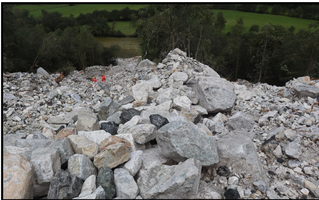
Figur 6 - Vegvesenets folk bli små i skredløpet ved Hagagrovi. Foto: I B Hynne
