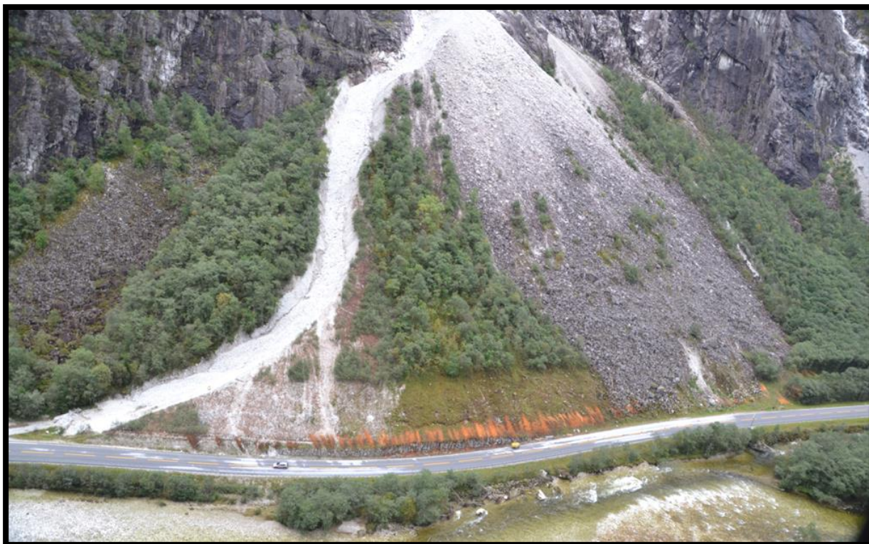
Figur 7 - Skredpunktet Hylland med voll/magasin og arbeidsområde for fanggjerde. Foto: J Tveit, SVV
