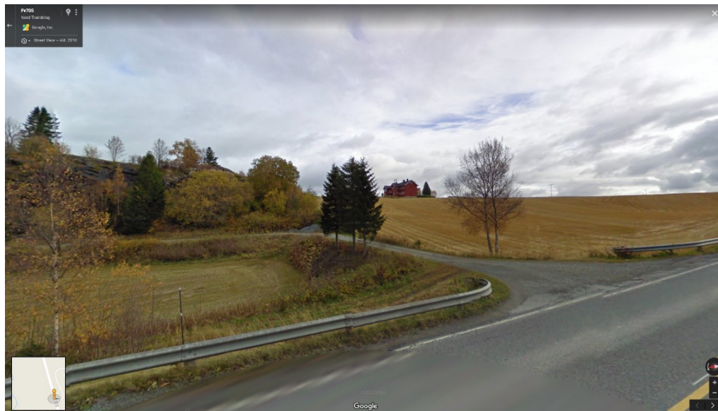
Fig. 06: Prosjektområdet ved borhull AV-22 – AV-25 (synlig ca. prof. 1450 – ca. 1600) som er behandlet i kap. 4.7., synsretning mot sør, den planlagte G/S-v. skal ligge til venstre på fylling, fyllingshøyde maks. ca. 3,5m (AV-23), her kan også ligge den ønskete undergangen, bildet tatt fra Google maps
