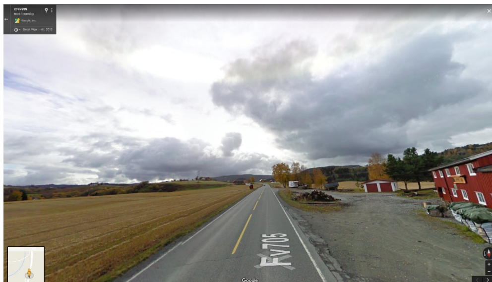
Fig. 04: Prosjektområdet ved borhull AV-06 – AV-10 (synlig ca. prof. 500 – ca. 900) som er behandlet i kap. 4.5., synsretning mot sør (Leira), den planlagte G/S-v. skal ligge til venstre nesten i terrengnivå eller på lav fylling, fyllingshøyde maks. ca. 1,5m (AV-10), til høyre Lerens sag med bekken Fugla, bildet tatt fra Google maps
