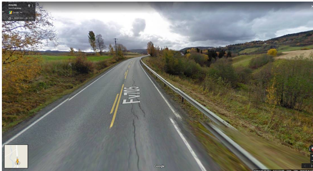
Fig. 03: Prosjektområdet ved borhull AV-03 – AV-06 (synlig ca. prof. 280 – ca. 500) som er behandlet i kap. 4.5., skjæringshøyde maks ca. 2m, synsretning mot sør, den planlagte G/S-v. skal ligge til venstre i lav skjæring eller nesten i terrengnivå eller på lav fylling, til høyre skråningen ned mot bekken Fugla, bildet tatt fra Google maps
