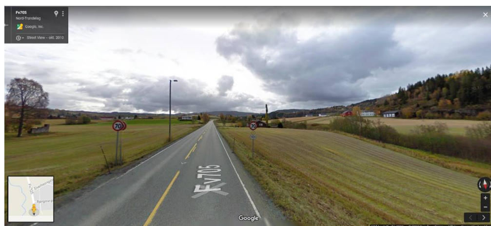
Fig. 02: Prosjektområdet ved borhull AV-01 – AV-02 (prof. 0 – ca. 280) som er behandlet i kap. 4.4., fyllingshøyde maks. ca. 2m, synsretning mot sør, den planlagte G/S-v. skal ligge til venstre på lav fylling, til høyre skråningen ned mot bekken Fugla, bildet tatt fra Google maps
