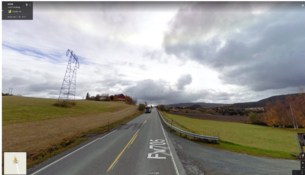
Fig. 05: Prosjektområdet ved Leira / Frammigårdsberget med grunt fjell ved borhull AV-16 – AV-19 (synlig ca. prof. 1150 – ca. 1300) som er behandlet i kap. 4.7., skjæringshøyde maks ca. 3m, synsretning mot sør, den planlagte G/S-v. skal ligge til venstre i lav skjæring eller nesten i terrengnivå, til høyre skråningen ned mot bekken Fugla, bildet tatt fra Google maps
