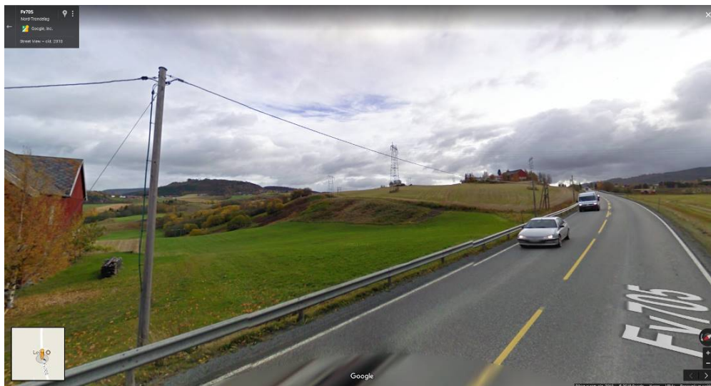
Fig. 05: Prosjektområdet ved borhull AV-11 – AV-15 ved Leira (prof. 1000 – ca. 1150) som er behandlet i kap. 4.6., fyllingshøyde maks. ca. 4m, synsretning mot sør, den planlagte G/S-v. skal ligge til venstre på fylling, til venstre også skråningen og dalsøkket ned mot den historiske skredgroppen og elven Leksa, bildet tatt fra Google maps
