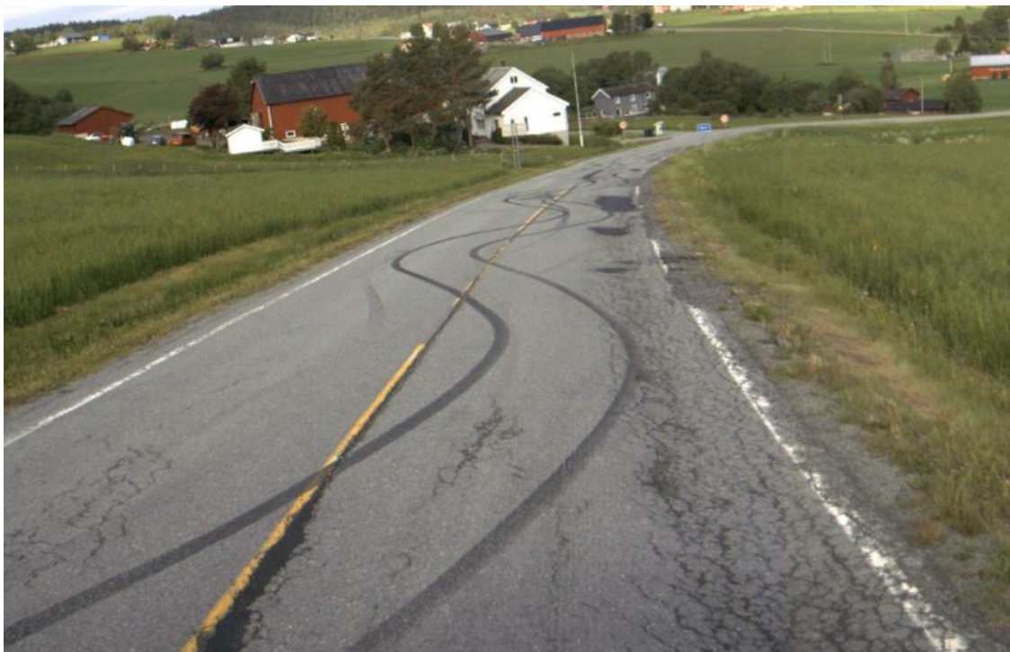
Figur 9 Kantskader Fv 709 S2D1 m 1500-2000, sett i F2
