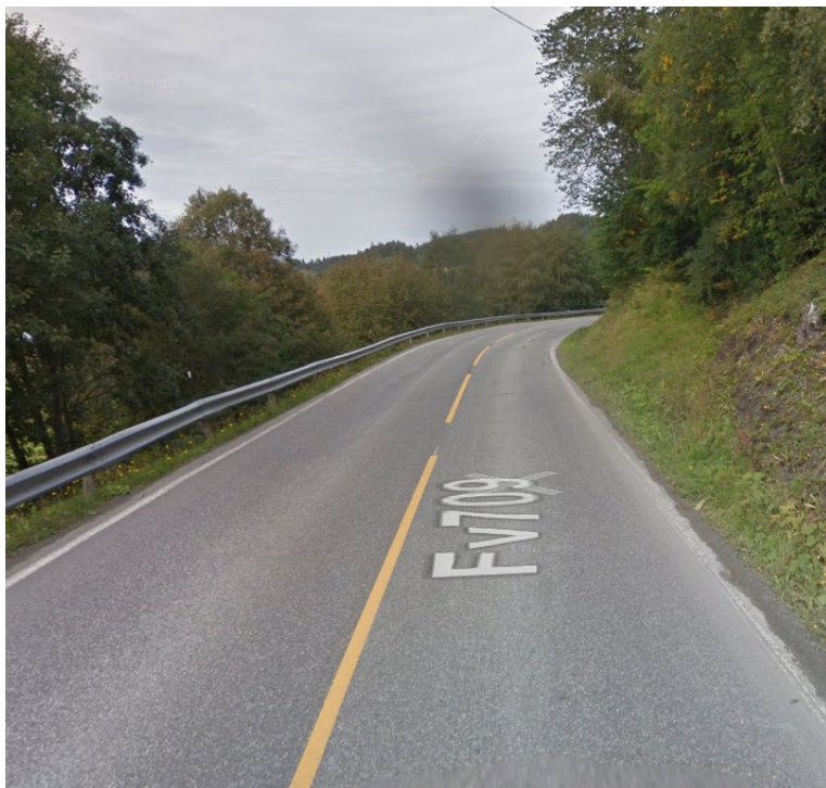
Figur 1 Kurve ved S1D1 meter 6700 sett fra sør
