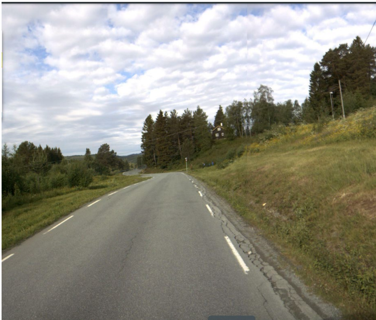
Figur 12 Dekkeskader m5942 i 2021
