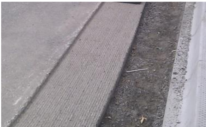
Figur 5.2: Renskjært asfaltkant og utfresing for fortanning. (Kilde: Vemax.no)
