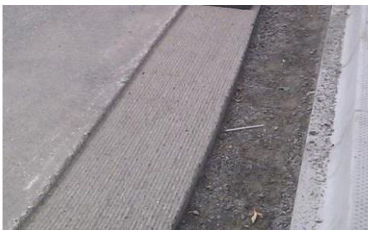
Figur 1: Renskjært asfaltkant og utfresing for fortanning. (Kilde: Vemax.no)
