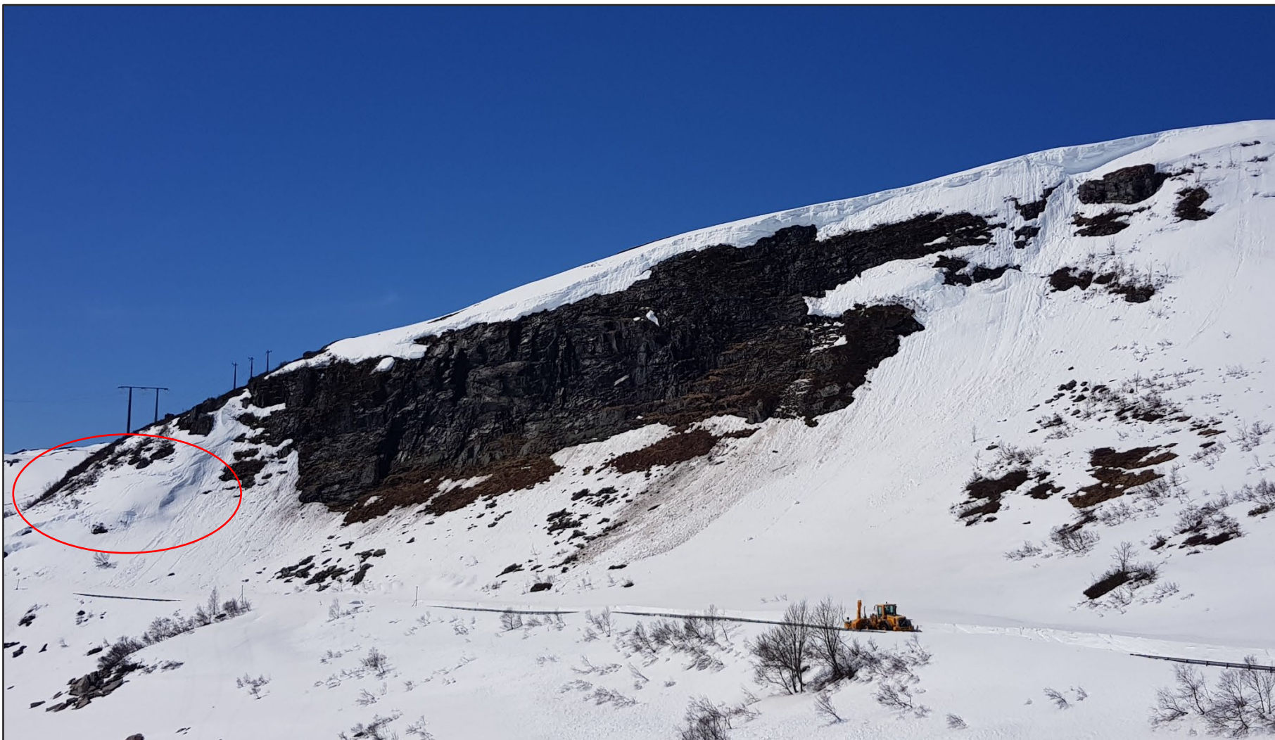
Figur 2: Ved skredpunktet Fridalsvatnet 1 har det bygd seg opp skavlar på toppen av fjellsida. Det er observert nokre sigesprekker bakom /innafor skavlane. Lengst til venstre markert med raud runding er det observert sigesprekker i snødekket.
