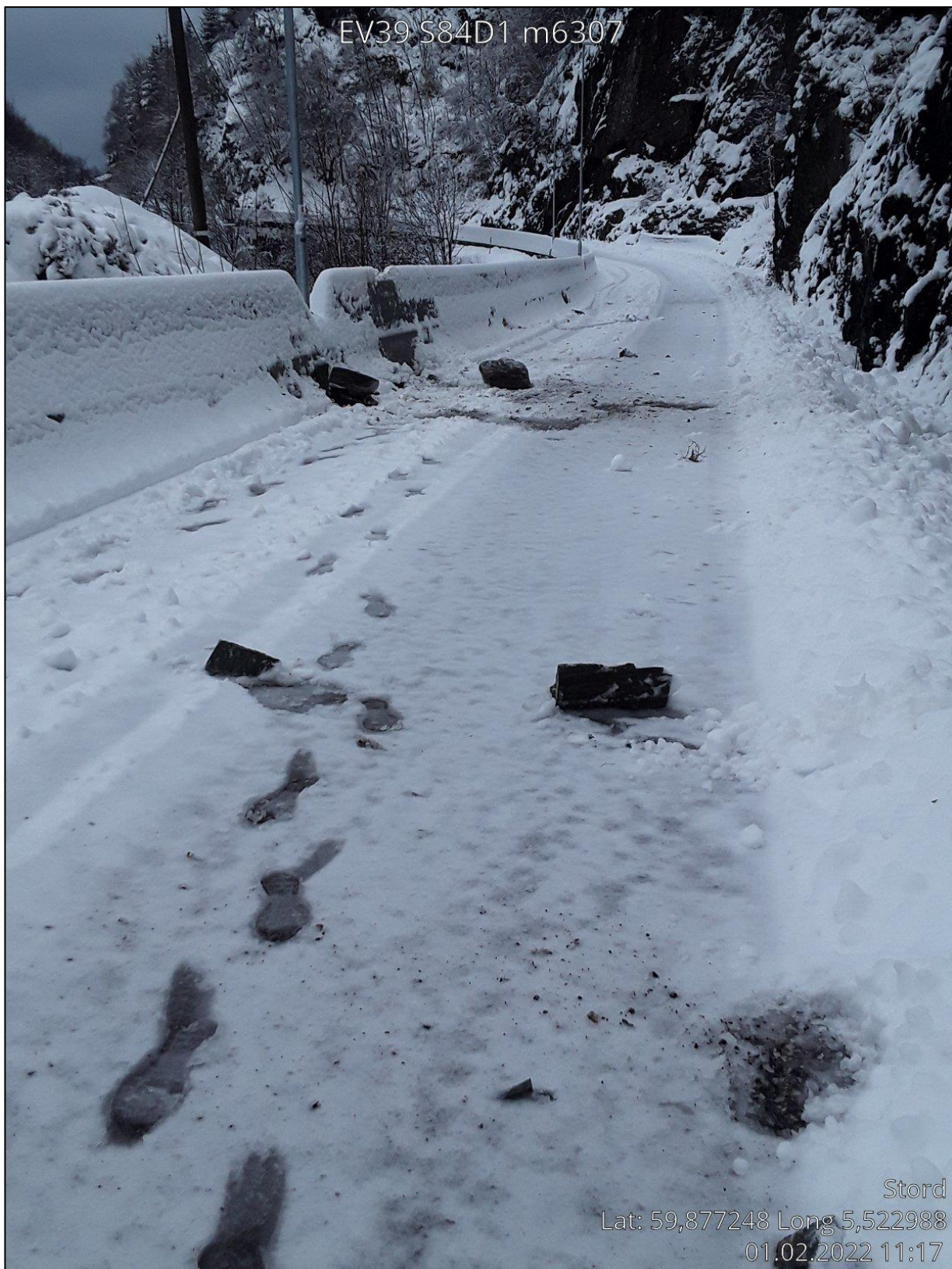
Figur 2. Foto av nedfall 01.02.2022. Foto hentet fra R11 med løpenummer R11-36-1.
