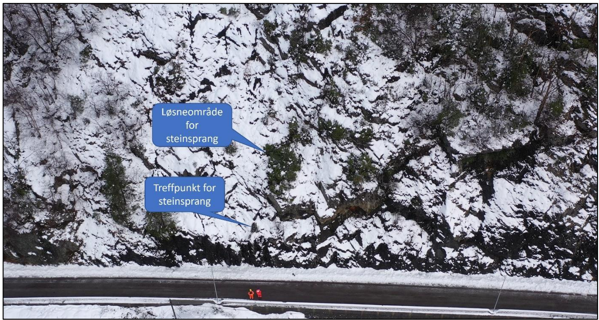
Figur 3. Mulig løsneområde antatt 01.02.2022. Dette foto ble oversendt byggeledelse og avisa Sunnhordaland.
