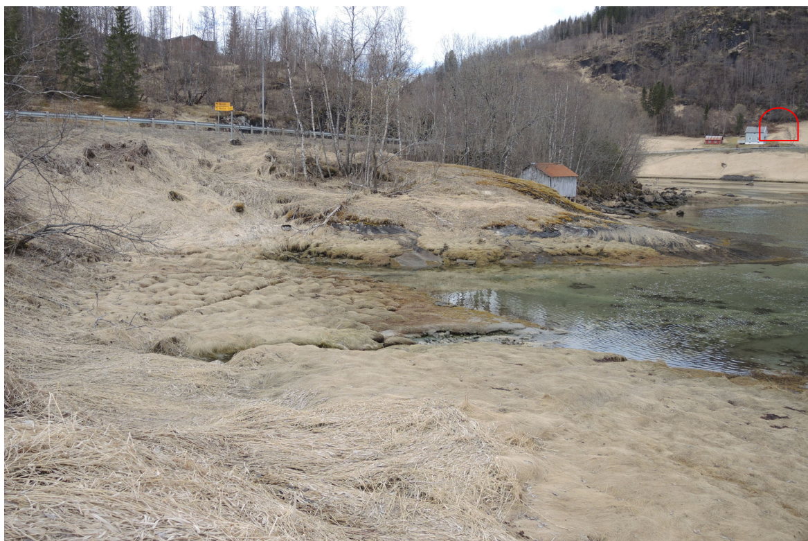
Figur 2. Ca. profil 150 tatt mot nordvest, i nedre kant sees utløpet til bekken som kan ses på tegn. V07. Erosjonssrikingen/motfyllingen langs elvekanten legges inntil berg i dagen. Påhugg til Megardskolltunnelen er markert med rødt.
