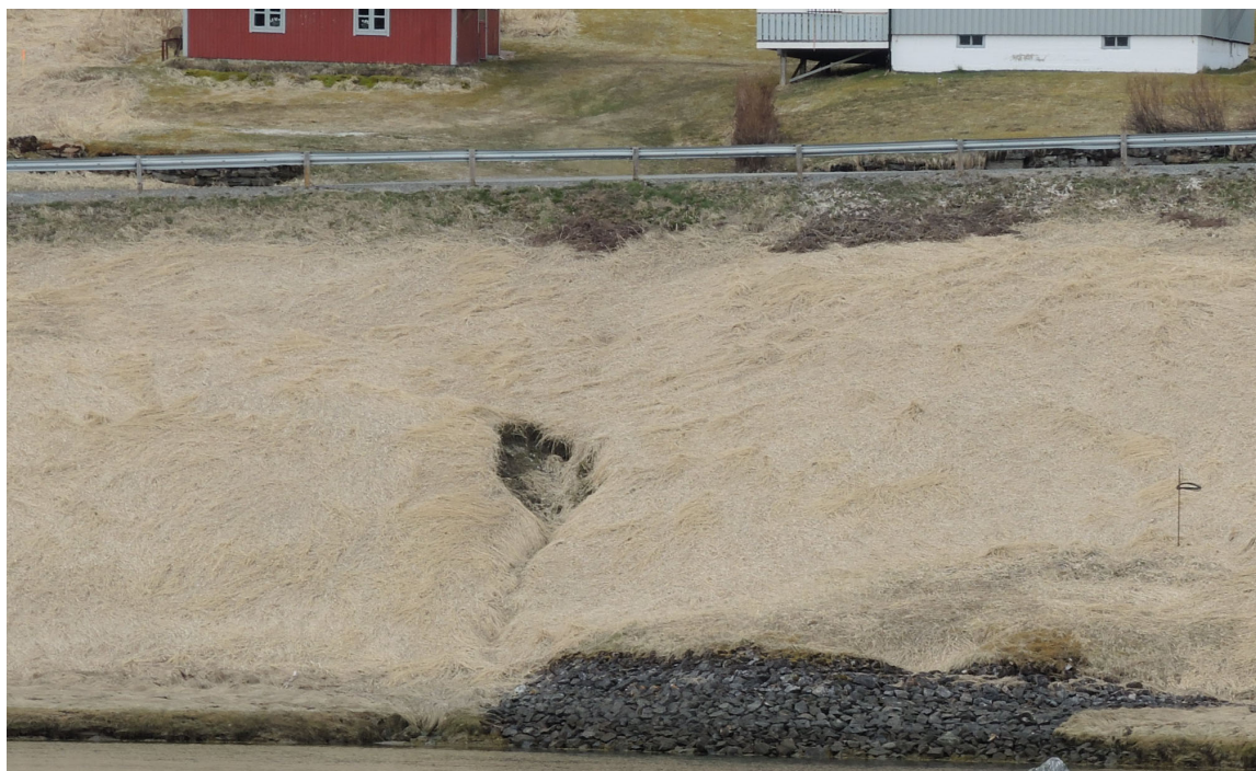
Figur 5. Detaljbilde på erosjonsskadene vist i Figur 3. Det er sen tidligere etablert en steinfylling i elvekant, ukjent alder, men antas å være etablerts som erosjonssikringstiltak etter erosjon/mindre utglidning i området. Poretrykksmåler 1509 til høyre i bilde.
