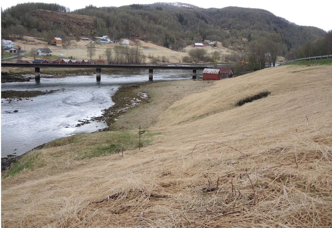
Figur 13. Elveskråning nord for Tørrfjordelva med eksisterende bru. Poretrykksmåler 1509 er synlig midt i bildet, samt erosjonsskader noe til høyre i bildet.
