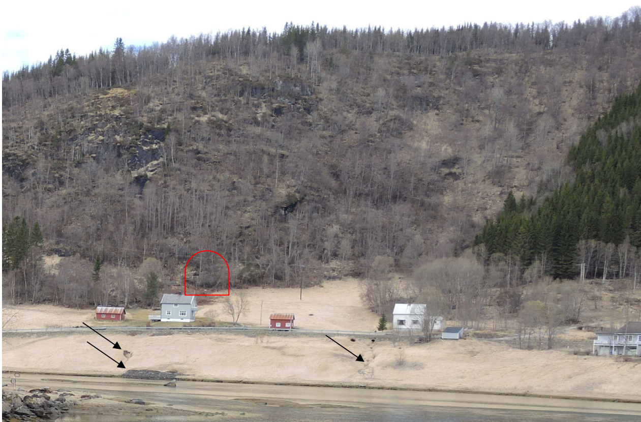
Figur 4. Lia nord for Tørrfjordelva, påhugg markert på bilden. I skråningen er det mulig å se erosjonsskader langs eksisterende vannveier, markert med pil. Her er det også mulig å se at de er etablert en steinfylling langs elva i underkant av erosjonsskadene, alder ukjent.
